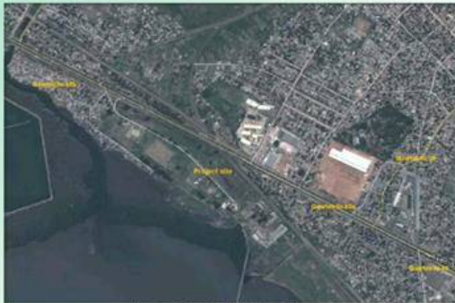
Localização da Central Térmica de Maputo
