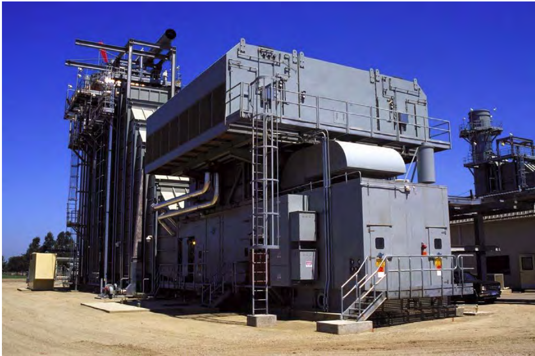
図6.2-6 ガスタービンパッケージ設置例
