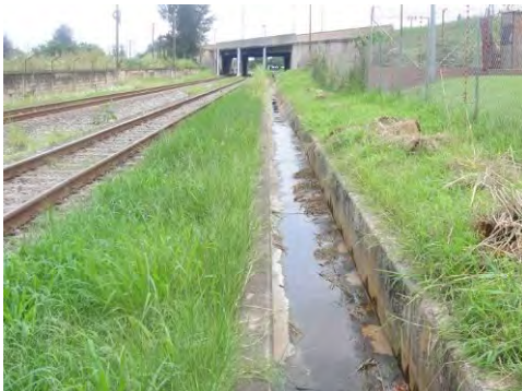
図6.6-6 鉄道脇の排水路（幅70cm）及びCTM構内の雨水枡
