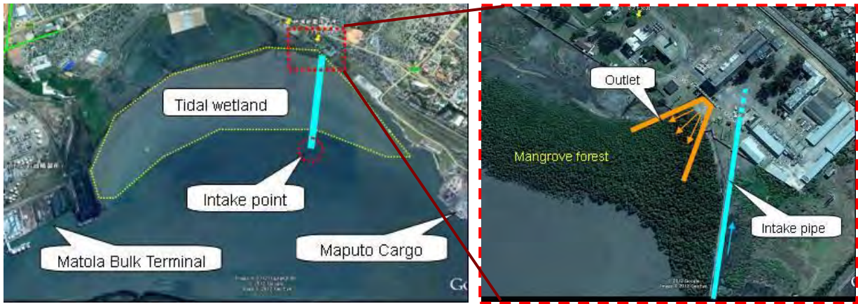
旧石炭火力発電所の取水位置（全景）
