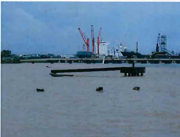
重油受入棧橋の現況
