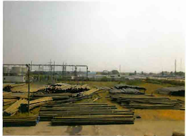
ブッシュロッド発電所内の配電用資材 (木柱)
