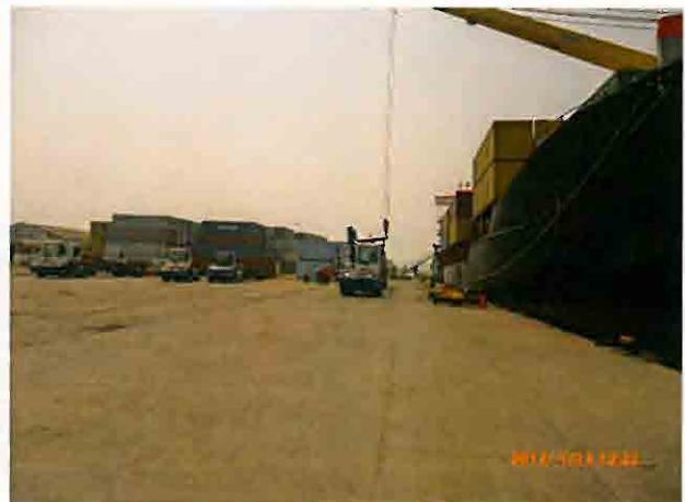
「リ」国の荷揚げ・港湾施設
