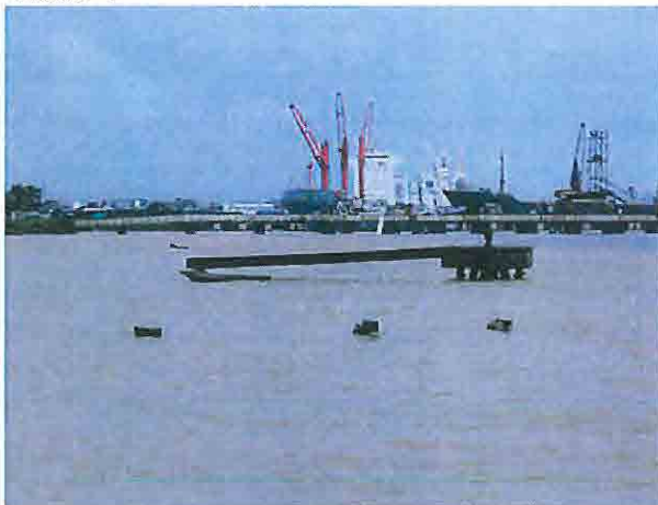
重油受入棧橋の現況
