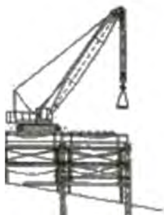
Pose de plaques de recouvrement
