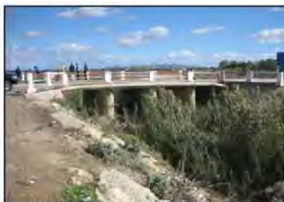
Figure 6.3-14 État actuel du pont d'El H'bibia (8.2012)
