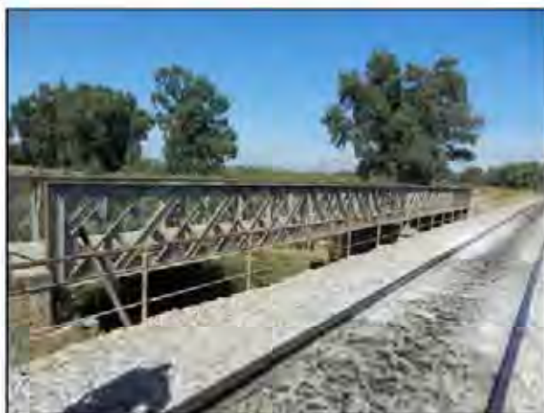
Figure 6.3-7 État actuel del'ancien pont ferroviaire de Jedeida (8.2012)
