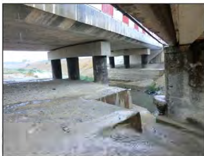
Figure 6.3-11 État actuel du pont GP7 sur l'oued Chafrou (8.2012)
