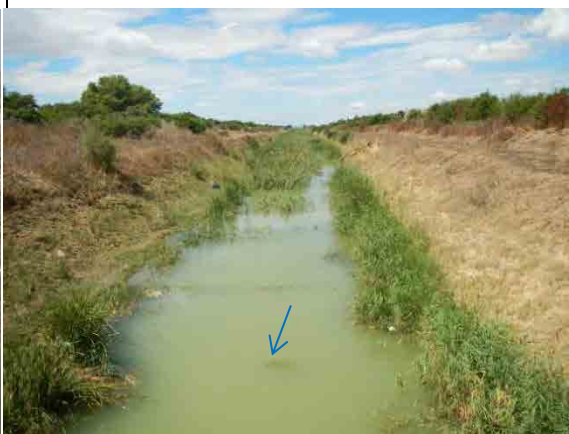
21. Canal d'évacuation à l'amont confluent avec Medjerda (Août 2012)
