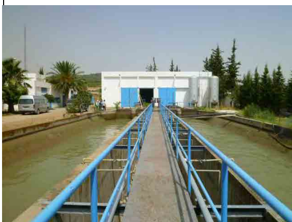
03. Prise d'eau d'El Herri (Prise d'eau de Medjerda) (Août 2012)
