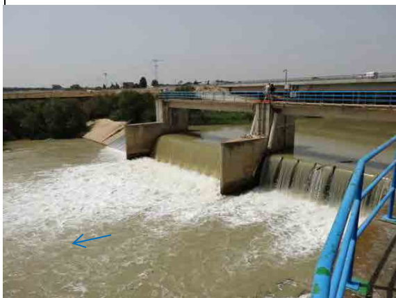
25. Barrage mobile de Tobias (Aval de Medjerda) (Août 2012)
