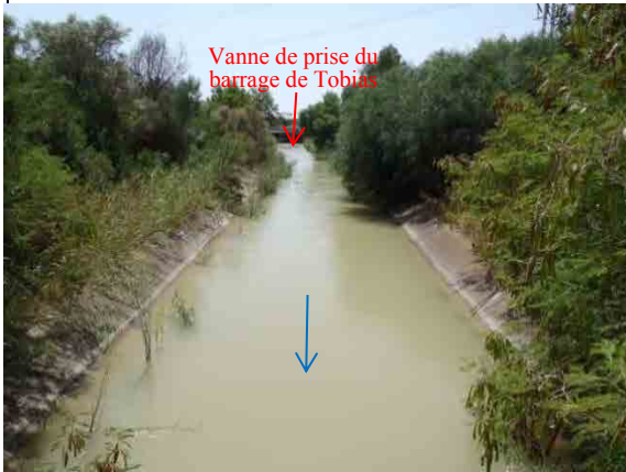
26. Canal d'entrée du barrage de Tobias (Août 2012)
