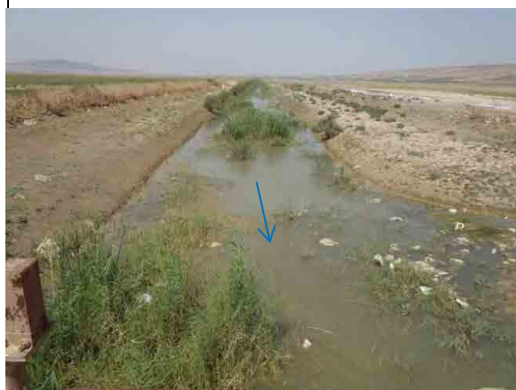
20. Canal d'évacuation à la vanne de régulation entre les zones 1 et 2 (Août 2008)
