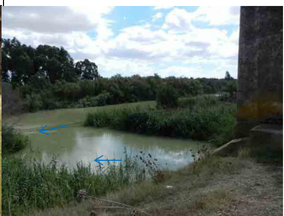
23. point d'entrée à partir du canal d'évacuation vers Medjerda (Août 2012)
