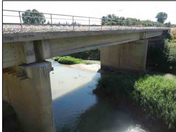
Figure 6.3-9 État actuel du pont ferroviaire de Jedeida (8.2012)
