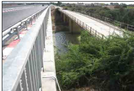
Figure 6.3-3 État actuel de l'ancien pont de Tobias (8.2012)
