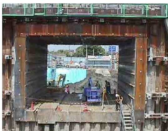
Figure 7-19 Creusement terminé
