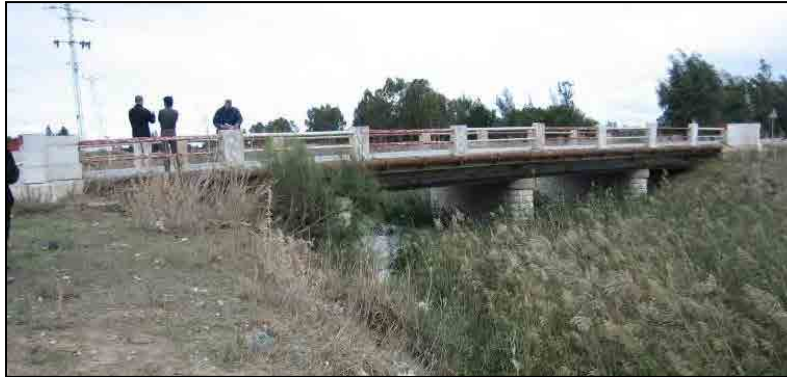
Figure 6.3-20 État actuel du pont GP8 et route sur l'oued Mabtouh (8.2012)
