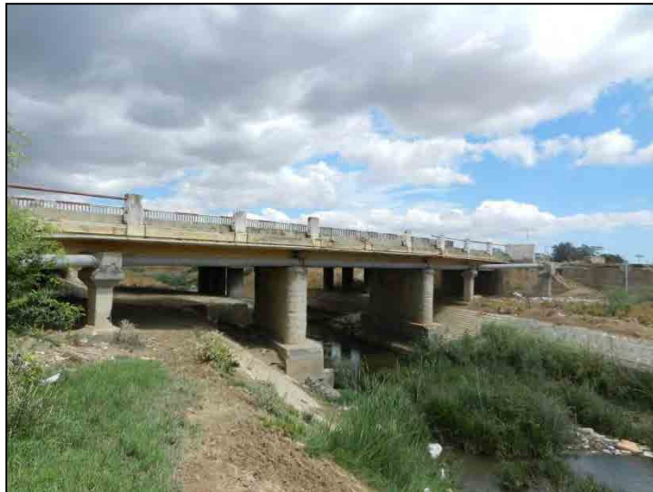
Figure 6.3-12 État actuel de l'ancien pont GP7 sur l'oued Chafrou (8.2012)
