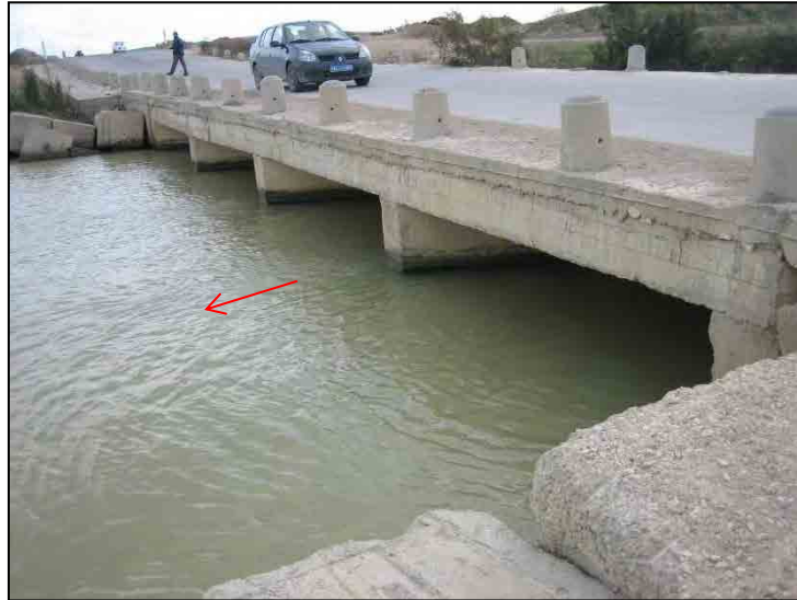
Figure6.3-1 L'état actuel du pont de K.Landalous (8.2012)
