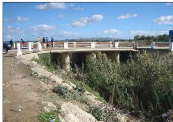
Figure 6.3-14 État actuel du pont d'El H'bibia (8.2012)
