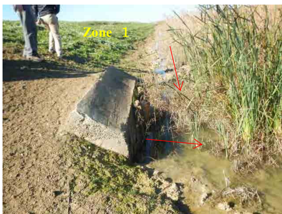
Figure 3-27 Volet rabattable de la sortie de tuyau
