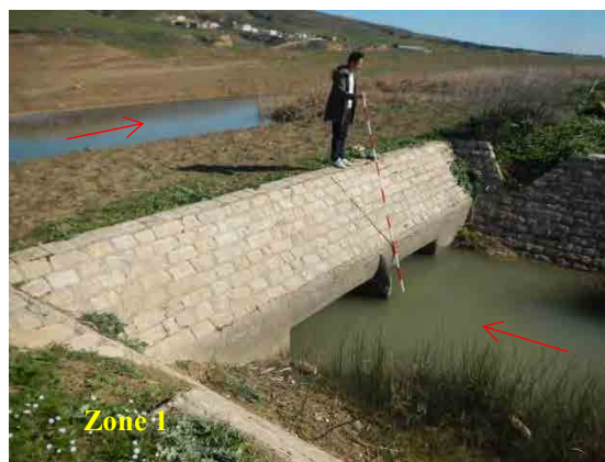
Figure 3-28 Tuyau d'évacuation en dalot
