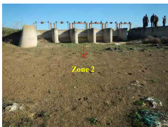
Figure 3-23 Déversoir équipé de vanne reliant la zone 2 et la zone 1
