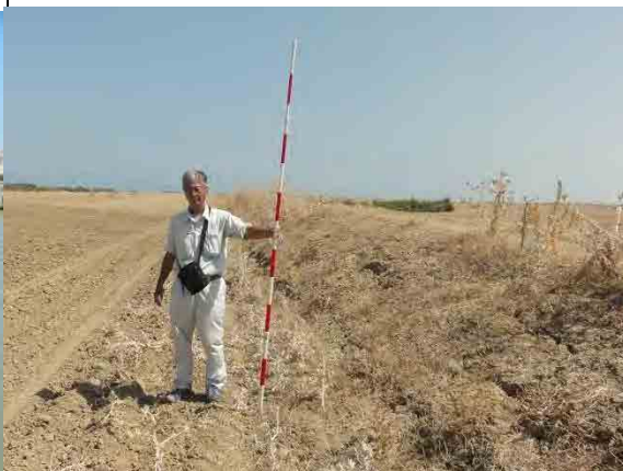
28. Situation de construction de digue de la rive droite à l'aval du pont Delta (Septembre 2012)
