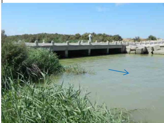
27. Aval du pont Delta (Septembre 2012)
