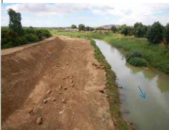
08.Situation de la construction de la digue de la rive droite à l'amont du pont GP7 Jedeida (Août 2012)
