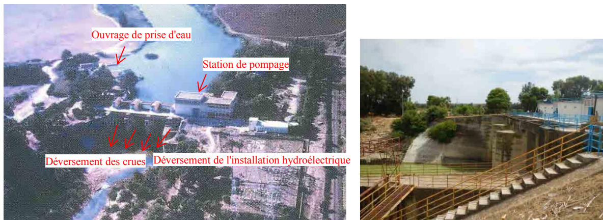
Figure 2-10 À gauche, vue d'ensemble du barrage Laroussia / À droite, vue d'ensemble du côté aval
