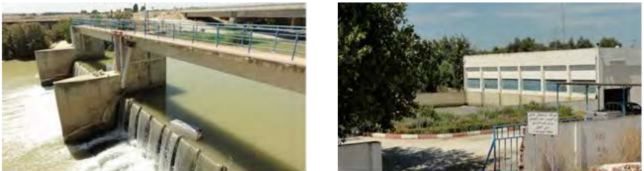
Figure 2-11 À gauche, les 2 vannes basculantes (au premier plan) et le barrage fixe / À droite, la station de pompage de l'ouvrage de prise d'eau sur la rive gauche, immédiatement en amont du barrage
