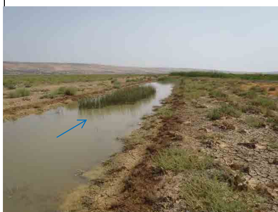
18. Canal d'évacuation du bassin de retardement d'El Mabtough (Août 2012)
