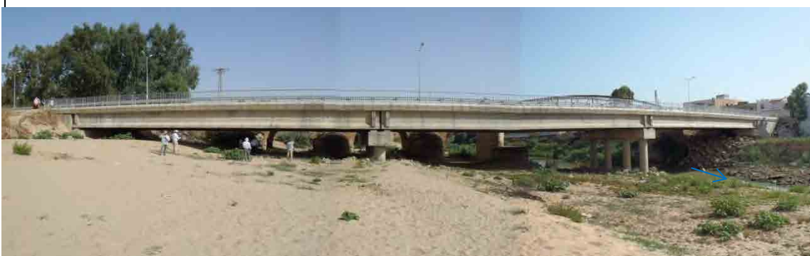
11.Situation de l'ensablement de l'entourage de la rive droite à proximité du nouveau et ancien ponts de Jedeida (Août 2012)
