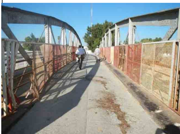
09.Ancien pont de Jedeida (Août 2012)
