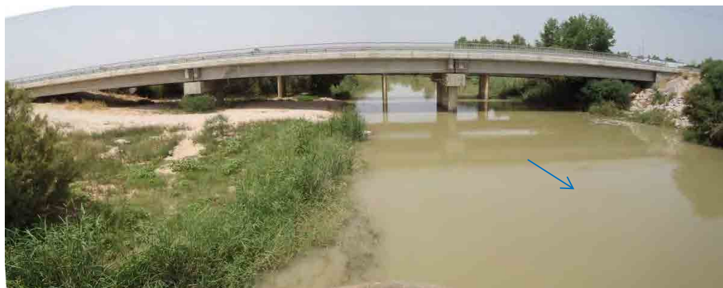
24. Pont à l'amont du barrage mobile de Tobias (Août 2012)
