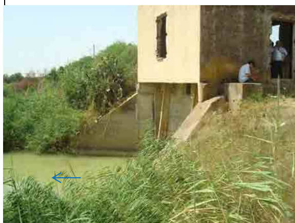
22. Ecluse du point d'entrée à partir du canal d'évacuation vers Medjerda (Août 2012)
