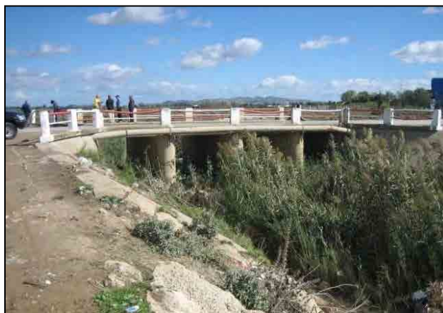
図 6.3-14 El H'Bibia Bridge 橋の現況 (2012.8)
