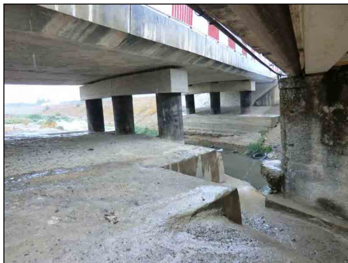
図 6.3-11 GP7 Bridge on Chafurou 橋の現況 (2012.8)
