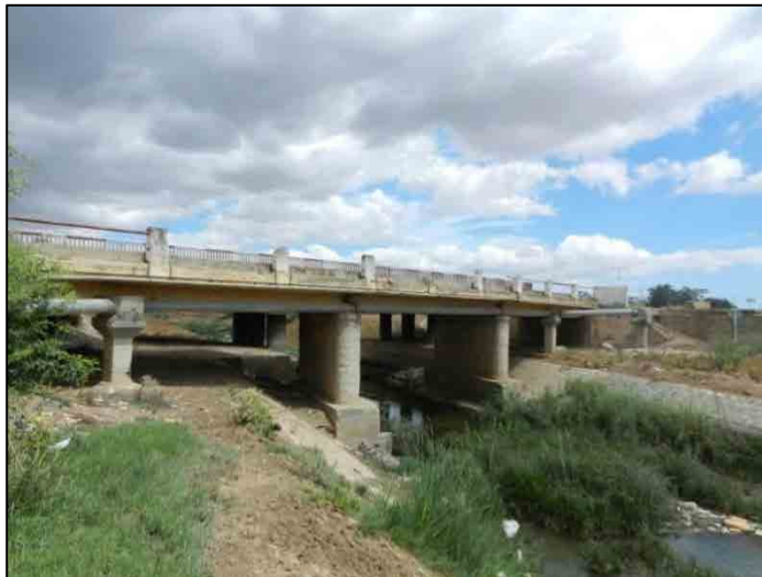
図 6.3-12 GP7 Old Bridge on Chafrou 橋の現況 (2012.8)
