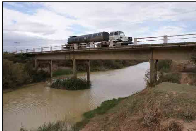
図 6.3-5 GP8 Bridge Over Oued Mejerda 橋の現況 (2012.8)
