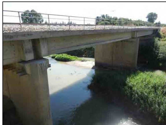
図 6.3-9 Jedeida Railway Bridge 橋の現況 (2012.8)
