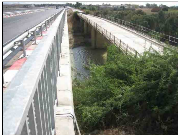
図 6.3-3 Tobias Old Bridge の現況 (2012.8)
