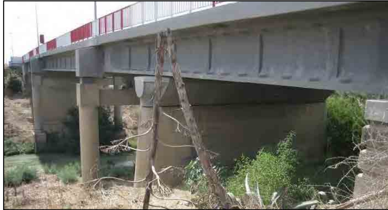
図 6.3-10 Jeeda Bridge on GP7 橋の現況 (2012.8)
