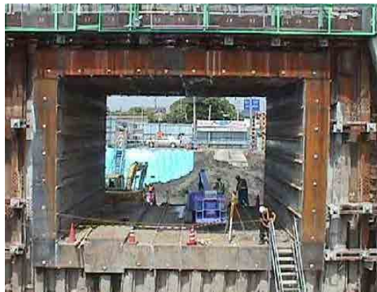
図 7- 掘削完了状況
