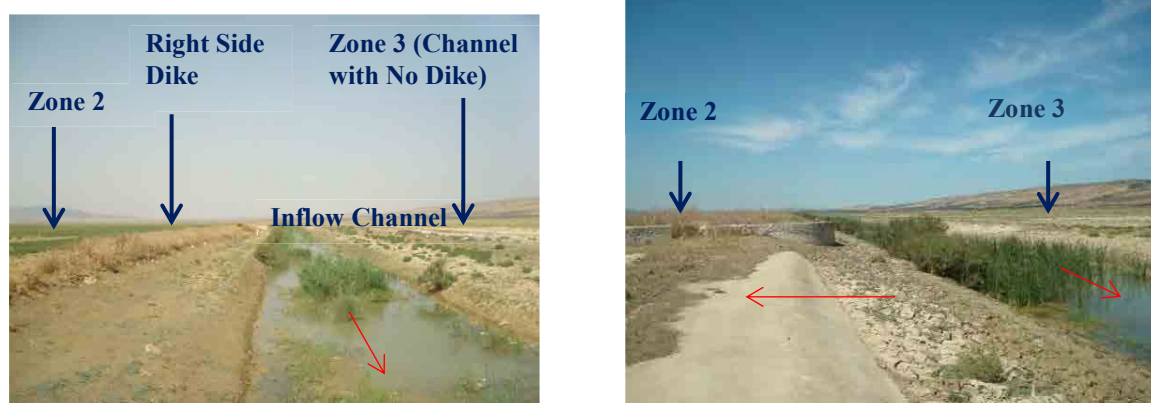
図 3- 越流堰(ゾーン3 から 2)と流入水路右岸堤防
