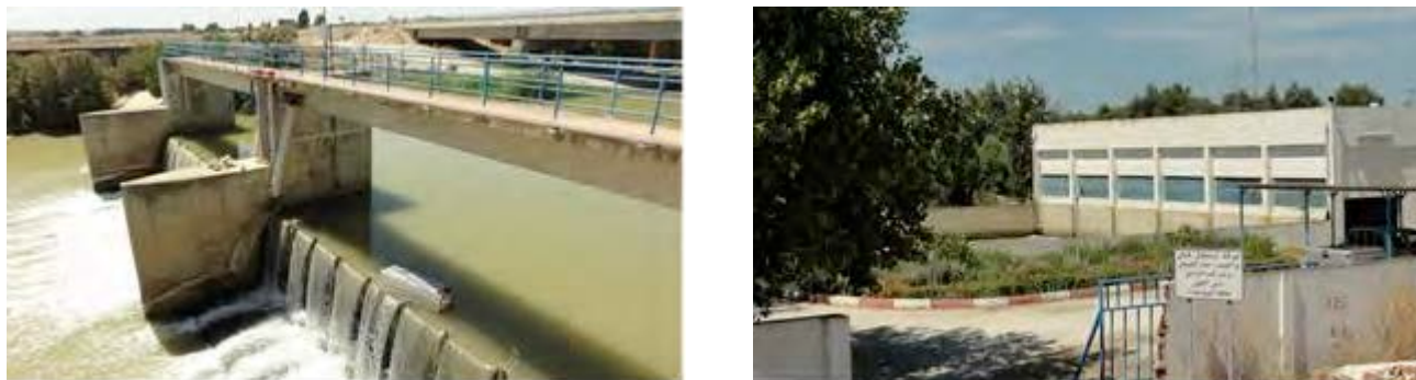
図 2- 左：転倒ゲート2門(手前側)と固定堰状況／右：直上流左岸側の取水施設のポンプ機場
