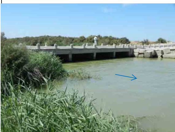
27. デルタ橋下流 (2012.09)
