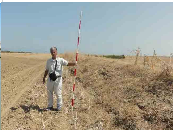
28. デルタ橋下流右岸の築堤状況 (2012.09)
