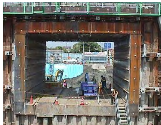
図 7- 掘削完了状況
