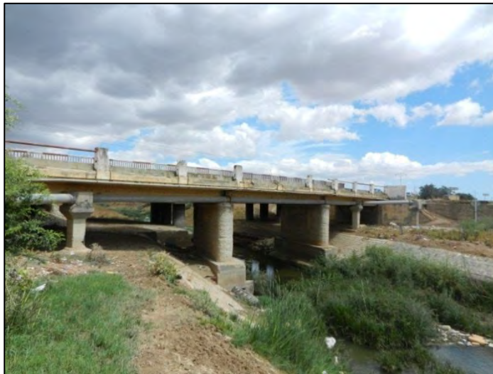
図 6.3-12 GP7 Old Bridge on Chafrou 橋の現況 (2012.8)
