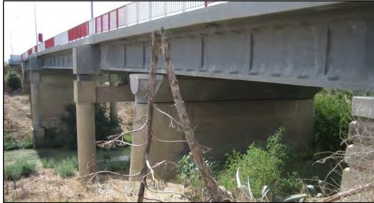
図 6.3-10 Jedeida Bridge on GP7 橋の現況 (2012.8)
