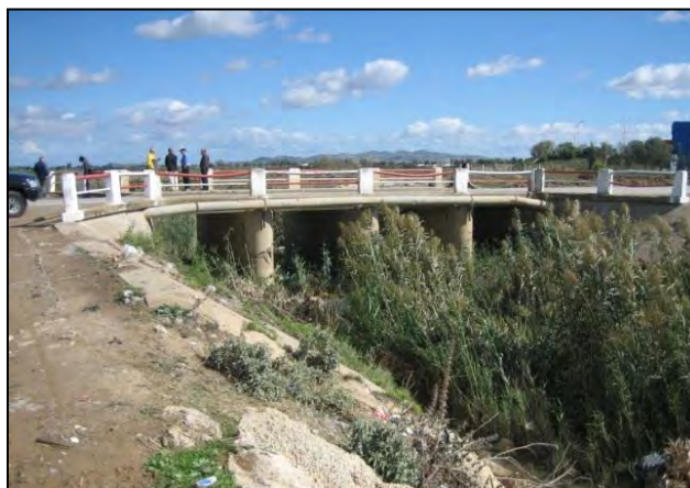
図 6.3-14 El H'Bibia Bridge 橋の現況 (2012.8)
