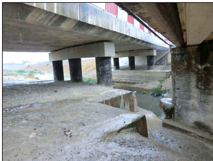
図 6.3-11 GP7 Bridge on Chafurou 橋の現況 (2012.8)
