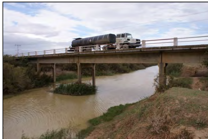
図 6.3-5 GP8 Bridge Over Oued Mejerda 橋の現況 (2012.8)
