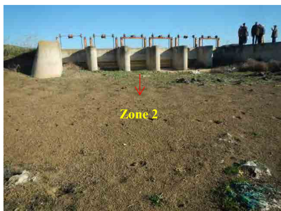
図 3-23 ゾーン 3 から 2 へのゲート付き越流堰
