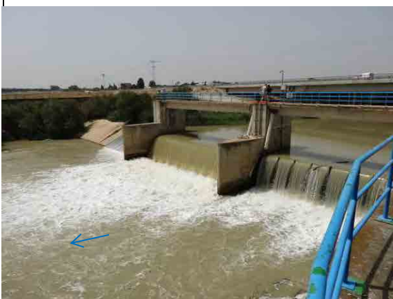
25. トビアス可動堰 (Mejerda 川下流) (2012.08)
