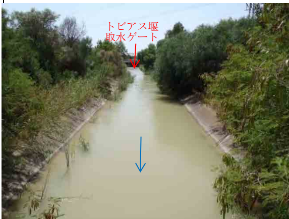
26. トビアス堰からの導水路 (2012.08)
