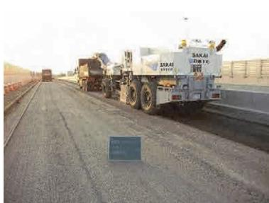
①路面切削機による切削
