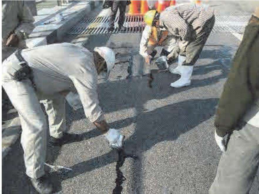
写真 3.3.3 補修材の充填作業
