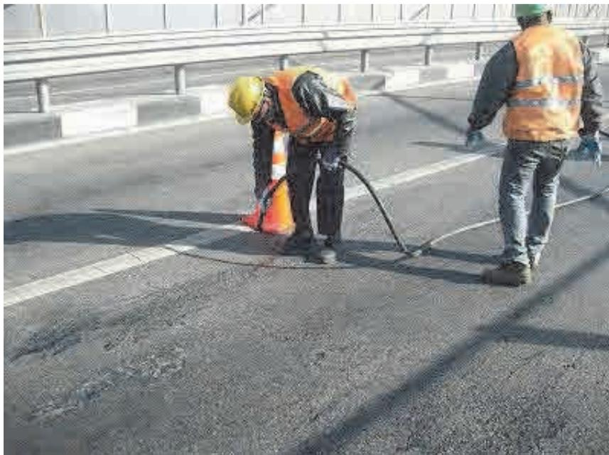
写真 3.3.2 コンプレッサーを用いたクラック内部の清掃作業
