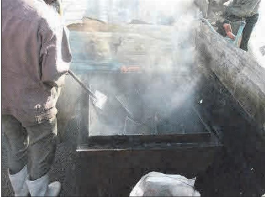
写真 3.3.1 溶解釜での注入材の溶解作業
