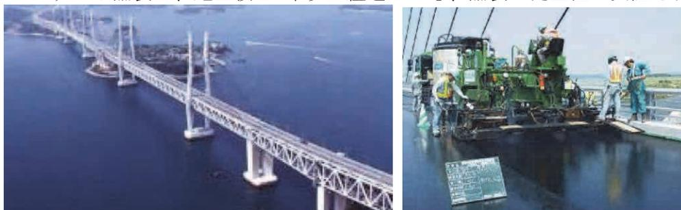
写真 5.1.1 長大橋でのグース施工例
