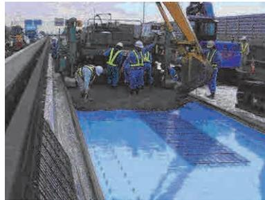
⑧補強材設置、SFRCの打設
