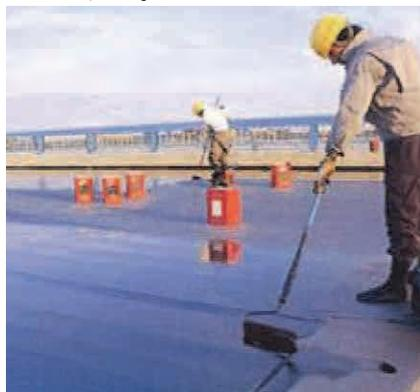
写真 5.2.2 接着層の施工状況
