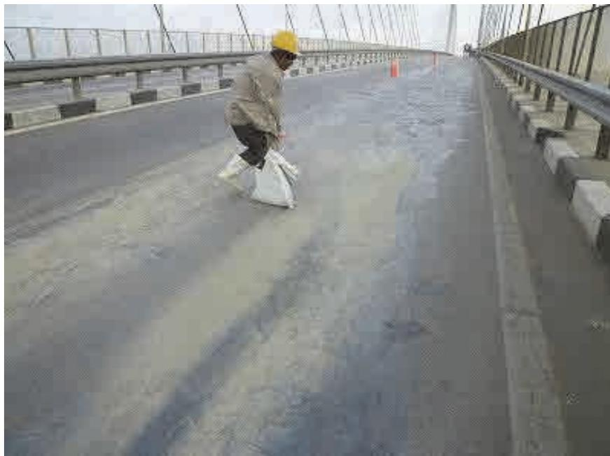
写真 3.3.4 補修材の充填後のセメントの散布作業
