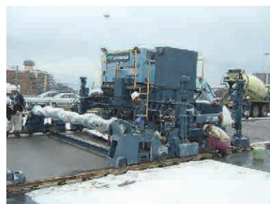
③フィンツァーによる締固め
