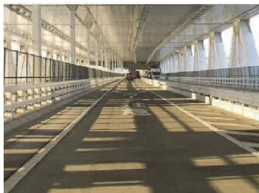
写真 5.1.4 横浜ベイブリッジ下層部 国道 357 の SFRC
