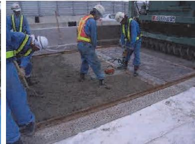
⑨パイププレートによる締固め
