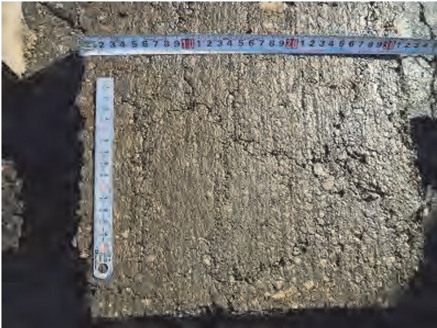
写真 2.2.13 開削した舗装ブロック下面（接着面） L2
