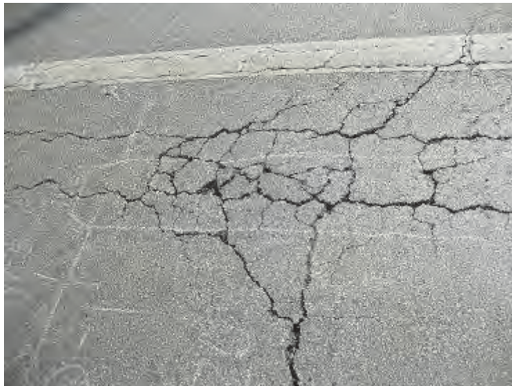
写真 2.2.5 車両走行位置の主要なひび割れ
