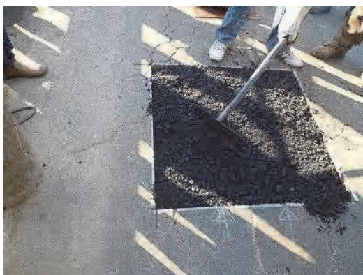
写真 2.2.11 アスファルト材による埋め戻し
