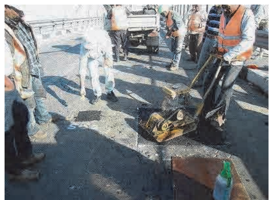
写真 2.2.11 アスファルト材による埋め戻し
