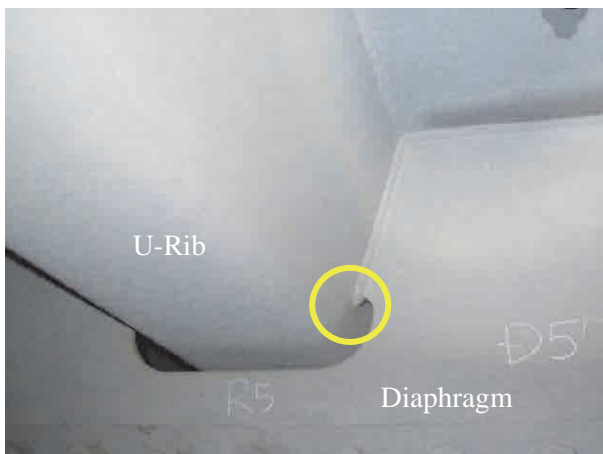
U-rib のスカーラップ端部回し溶接
