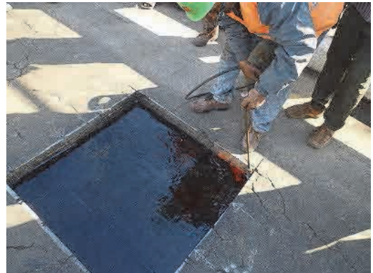
写真 2.2.10 舗装の切削と開削作業
