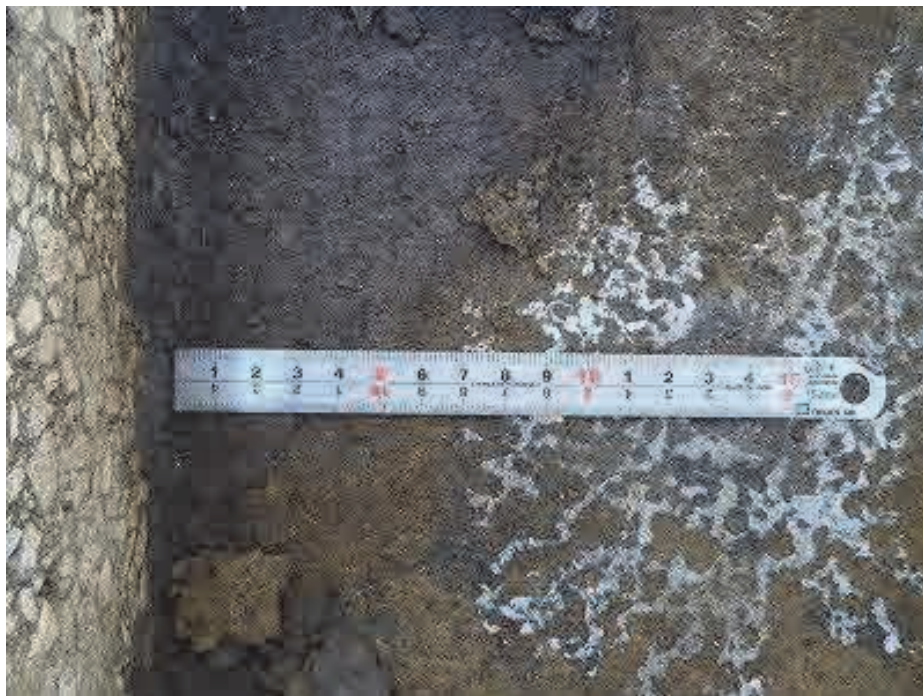
写真 2.2.14 鋼床版の接着層と錆の除去（L2）
