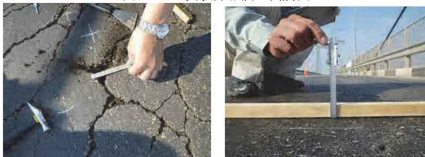
写真 2.2.4 変状詳細調査
