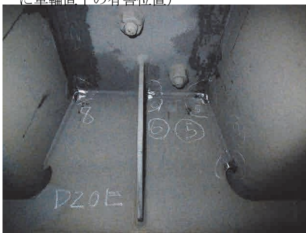
車輪直下のデッキプレートに回し溶接される架設用リブ
