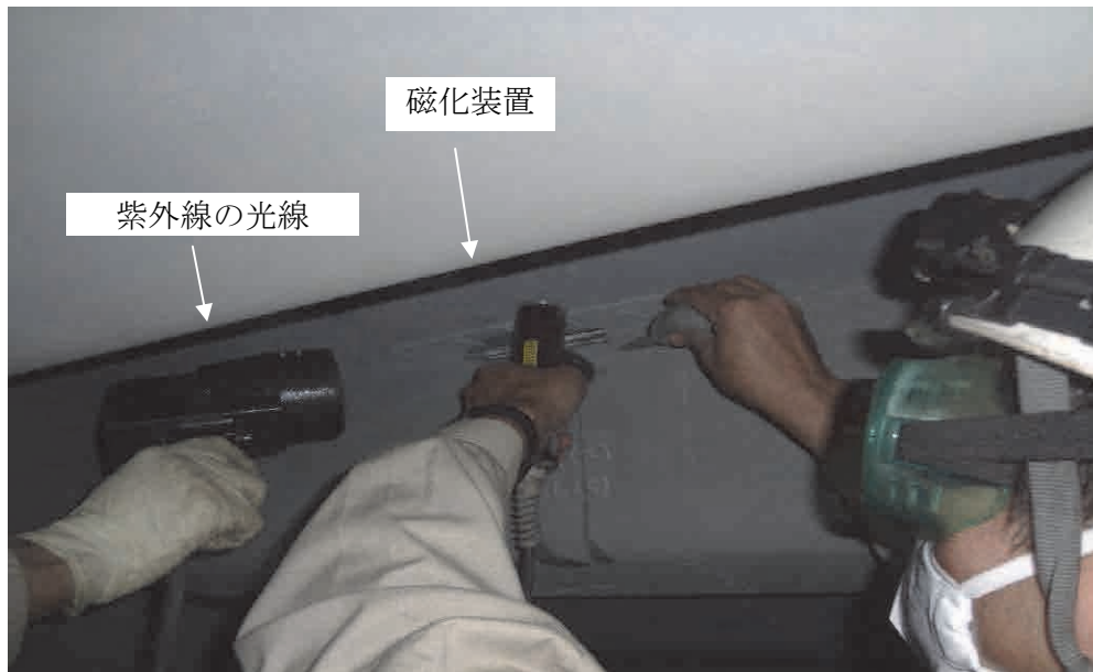
写真 2.3.12 舗装開削位置直下での磁粉探傷調査作業状況
