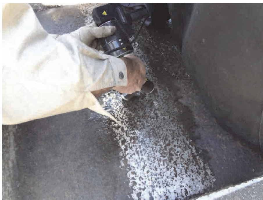
写真 2.3.11 デッキプレート上面での磁粉探傷調査作業状況
