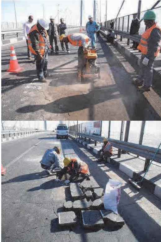
写真 2.2.10 舗装の切削と開削作業
