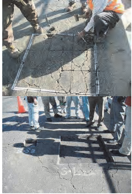
写真 2.2.10 舗装の切削と開削作業
