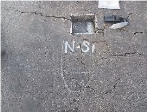
舗装撤去状況
