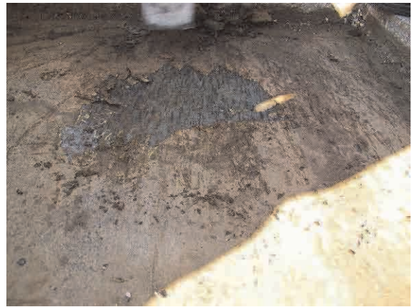
接着層（接着材と錆）
