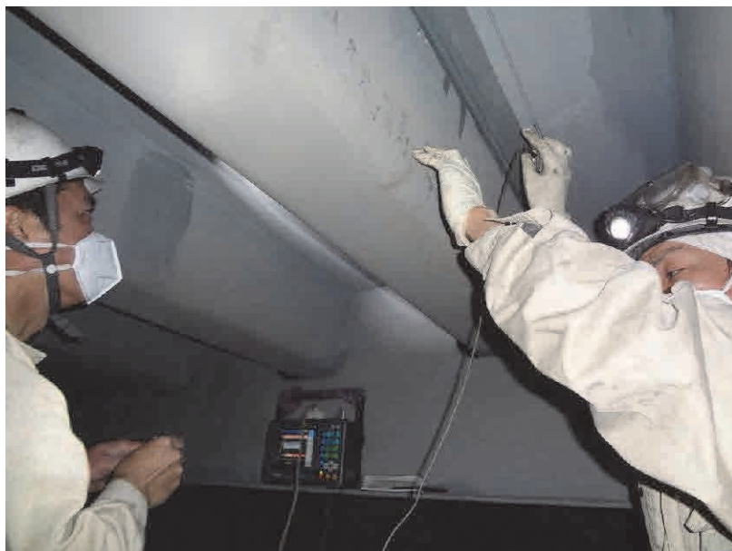
写真 2.3.17 超音波探傷調査作業状況
