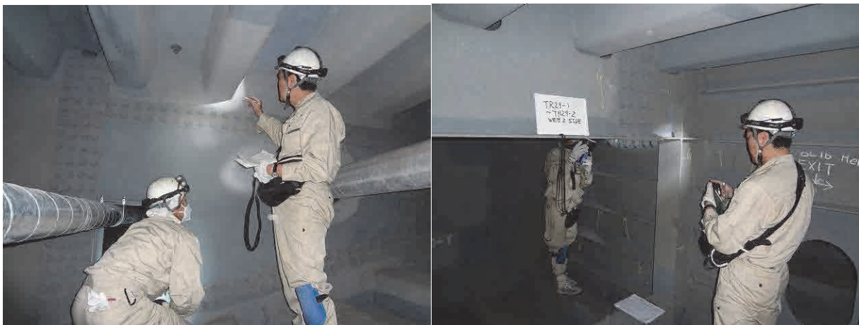
写真 2.3.7 鋼床版箱桁で実施された目視調査
