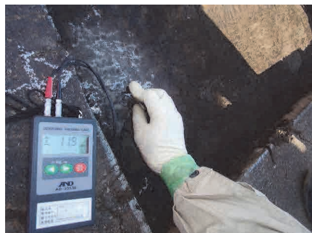
写真 2.3.6 デッキプレート板厚測定
