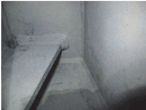
デッキプレートとの垂直補剛材溶接部（特に車輪直下の有害位置）
