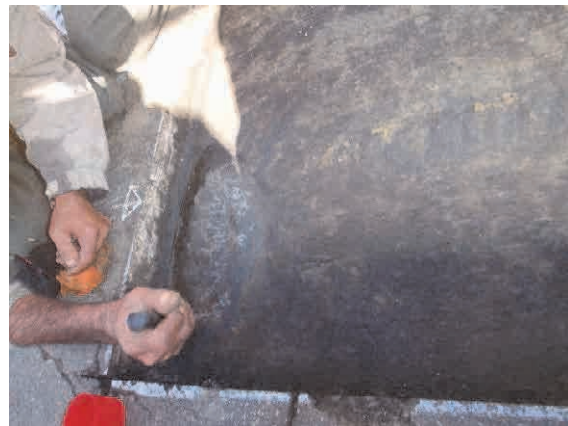
舗装撤去状況
