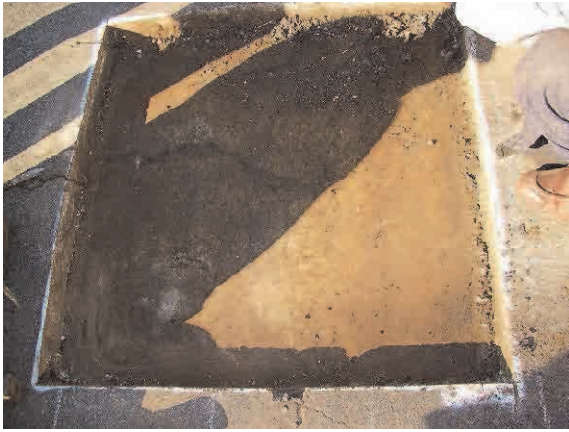
L1 の舗装撤去時に、接着層に付着した茶色物質を確認
