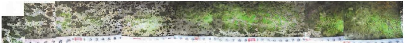
写真 2.3.14 デッキプレート上面の磁粉探傷調査結果
