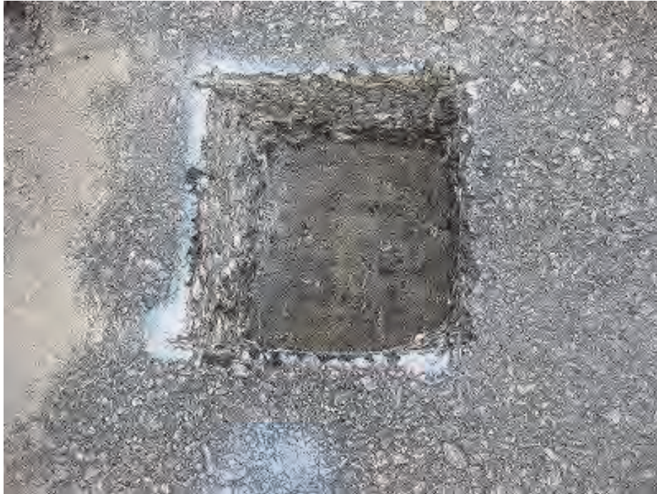
写真 2.2.16 追加調査箇所の開削調査状況（良好な箇所）SA2
