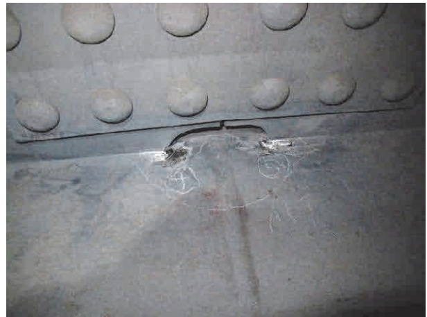
下フランジのスカーラップ溶接部
