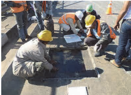
写真 2.2.10 舗装の切削と開削作業
