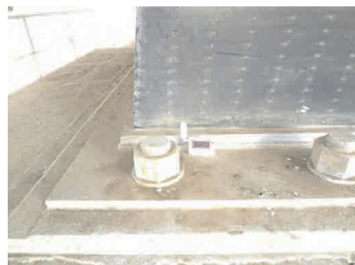
主塔1の箱桁外側（水平材上）
