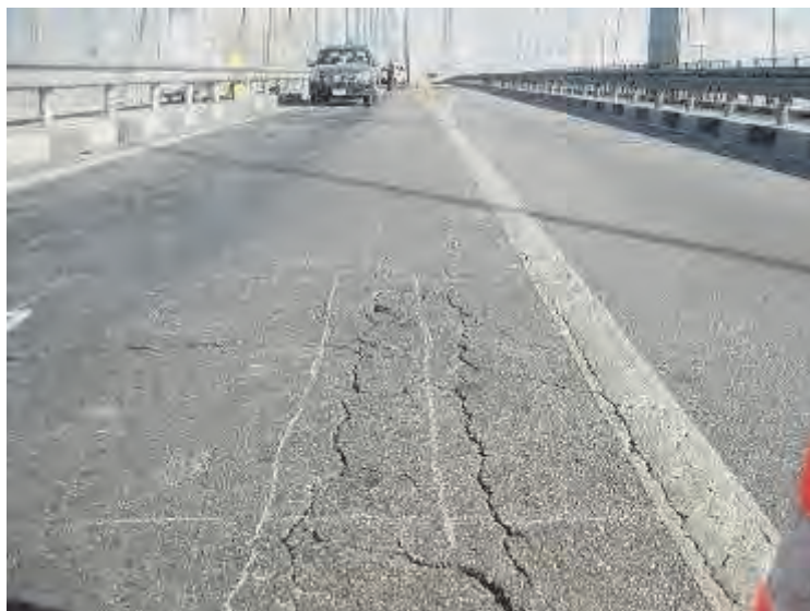
写真 2.2.6 リブプレート間に発生した主要なひび割れ
