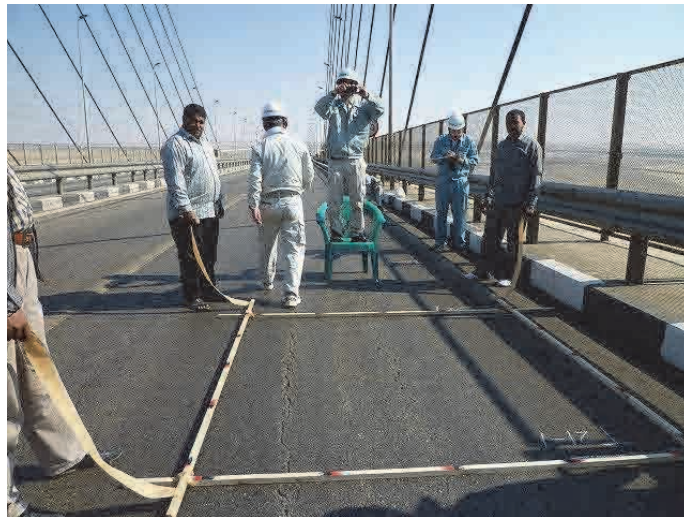
写真 2.2.1 舗装表面調査風景
