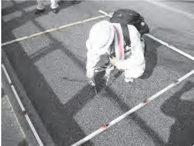
写真 2.2.3 ひび割れ幅及び深さ調査
