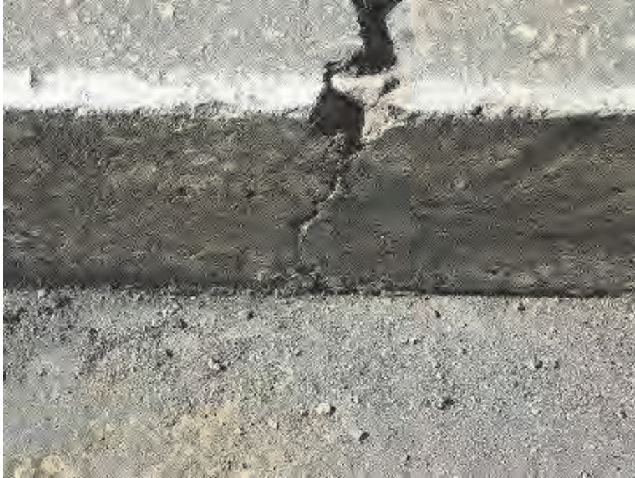
写真 2.2.12 舗装開削断面 (L2)
