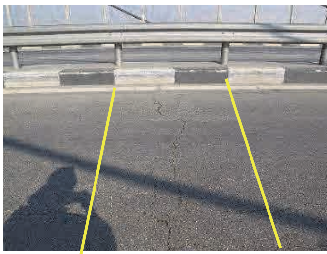
写真 2.2.7 ダイヤフラム間に発生した主要なひび割れ
