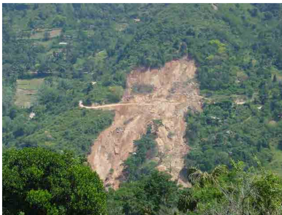
図 2-21 Walapane の地すべり(調査団提供)
