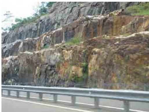
図3-5: 岩掘削の小段の例(スリランカ南部高速道路)
