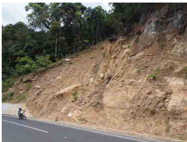
図 2-12 スリランカにおける斜面崩壊の実例
