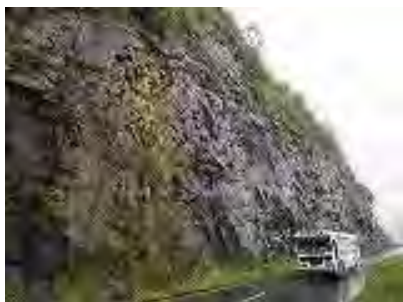
i) まだ新しい崩壊跡が残る絶壁。国道A005号線にて。
