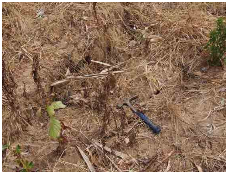
図4-5 A005-091 の斜面崩壊(沈下と開口を伴うテンション・クラック)
