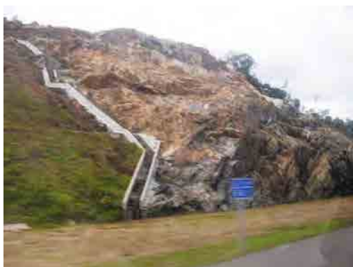
図3-6: 法面表面排水工(スリランカ南部高速道路)
