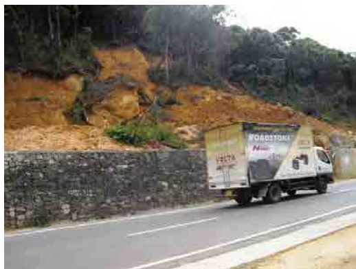
図3-9:フトンかごによる地すべり対策工(A-05 道路 83km、ヌワラエリア)
