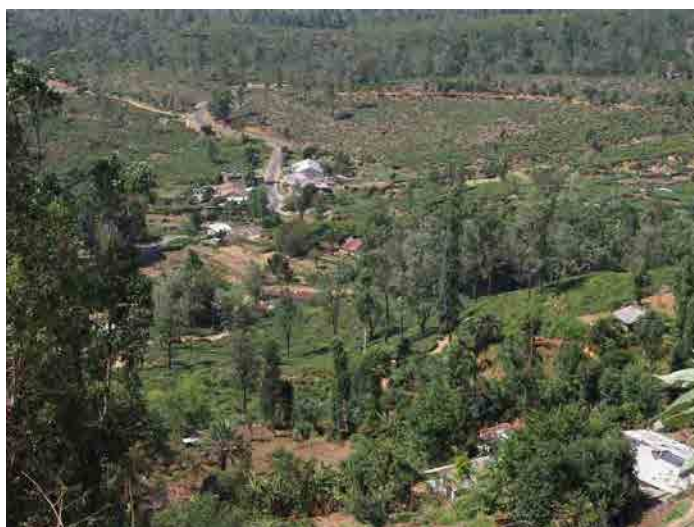
図4-8 B413-070 地すべり (地すべり中部)
