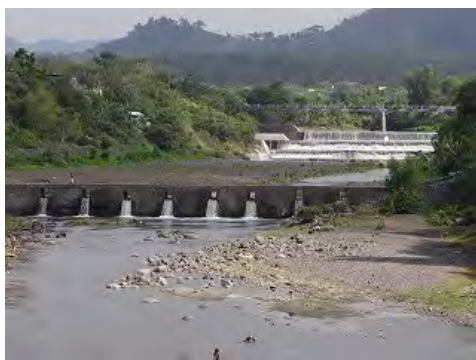
(1) Check (Sabo) Dam
