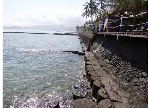
写真 7.4.3 ホテルやヴィラにより海岸線近傍に建設された護岸
