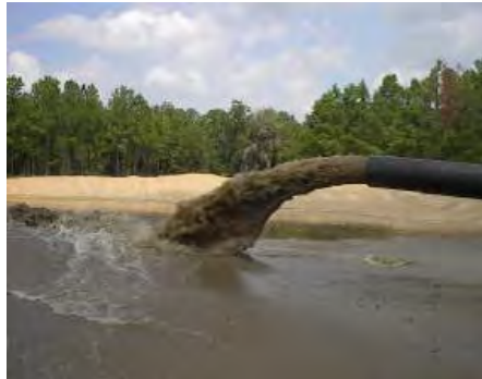
写真 14.4.8 養浜管からの直接養浜
