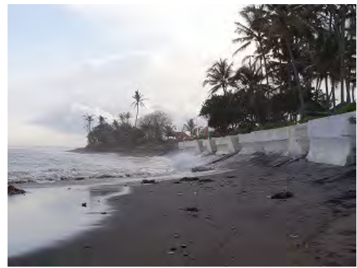
写真 8.2.2 前浜上に建設された護岸(Pabean)
