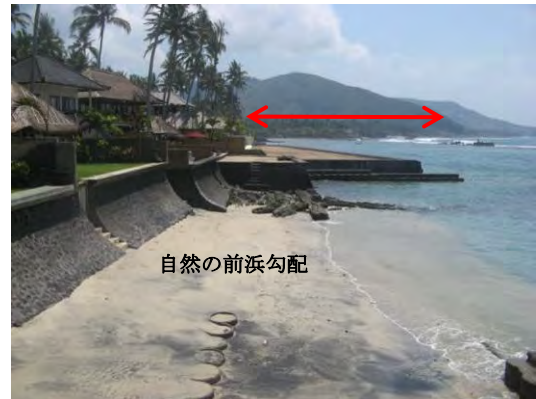
写真 8.2.1 個人ビラによる新たな前出し(チャンディダサ東部)
