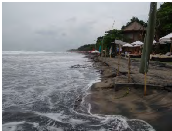
写真 11.3.8 敷地への波の遡上 (スミニャック)
