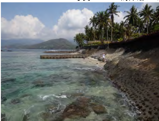
写真 11.3.4 海岸利用スペースの消失
