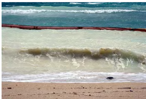
写真 14.4.10 汚濁防止スクリーンの設置による 懸濁物質の分離
