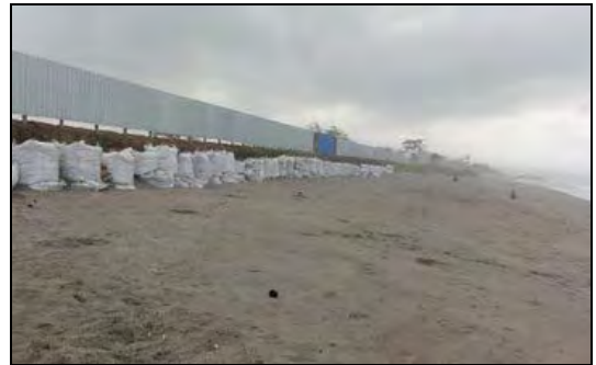
建設中の大型施設
