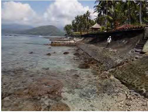
写真 7.4.3 ホテルやヴィラにより海岸線近傍に建設された護岸
