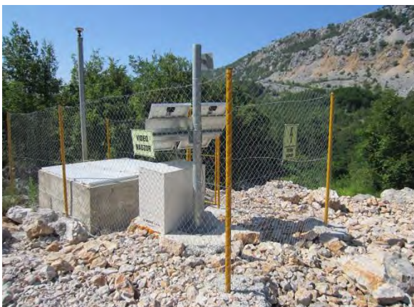
グロホボ地すべり地 (リエカ) の 機材設置箇所
