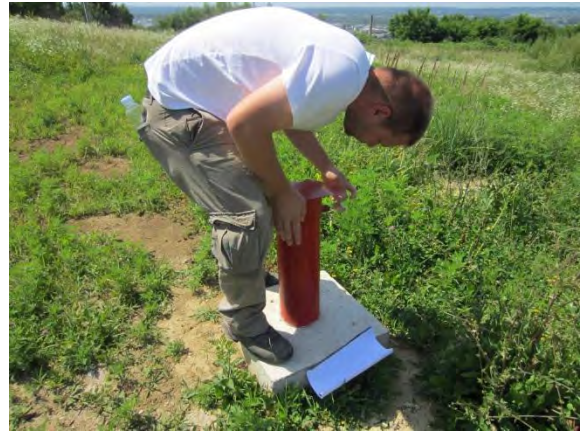
プロジェクトで孔内に設置した傾斜計 (コスタンジェック地すべり地)
