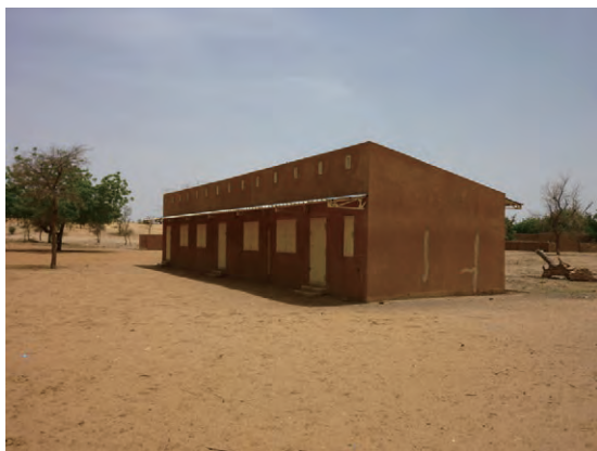
写真 23：フランス開発庁（AFD）支援による小 学校 外廊下に屋根がついたタイプの教室棟。
