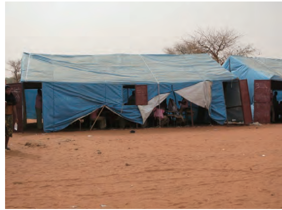
写真2：テントと藁を利用した仮設校舎 ユニセフ支援のテントを使用。窓が一つしかなく内部が暑くなるため、裾をめくっている。(I-2 第35シ・シワズ中学校)
