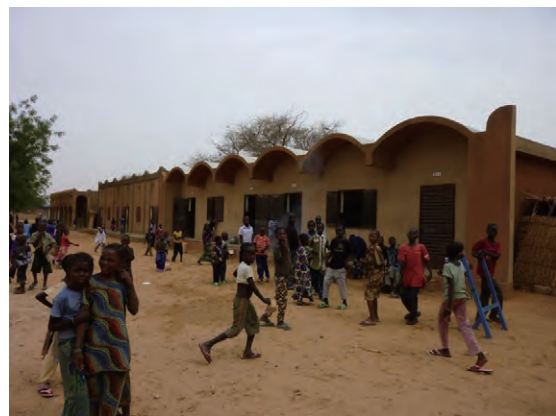
写真 24：ルクセンブルグ支援による小学校 屋根はソイルレンガで厚みがあり、断熱効果 が高いが、アスファルト防水の経年劣化が問題と なっている。
