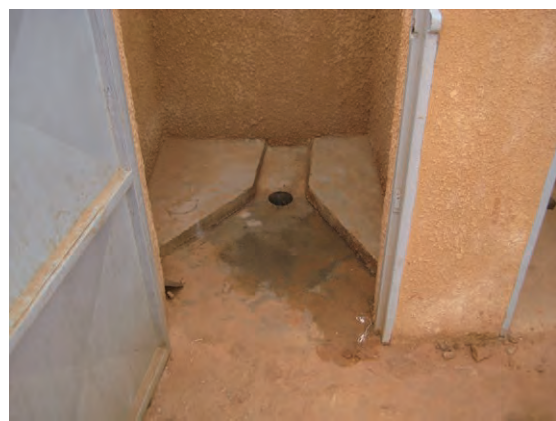
写真 14：既存トイレ内部 左のトイレのブース内部。便器がない形式。(Ⅱ-3 コラ・テギ中学校)
