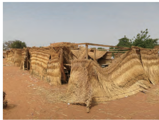
写真4：壊れた藁葺教室 強風で壊れた教室 (II-4 ダル・エス・サラム中学校)
