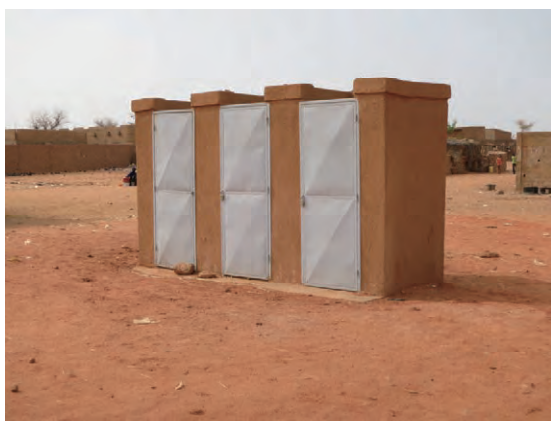
写真 13：既存トイレ ジェンダー配慮がなされておらず、目隠し壁がないトイレ棟。(Ⅱ-3 コラ・テギ中学校)
