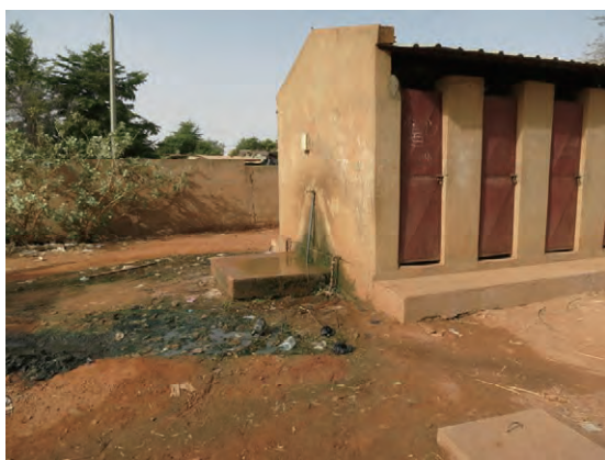
写真 11：既存トイレ トイレの外壁には水道が設置されている。 (I-1 フランス・アミエ・ニジェル中学校)
