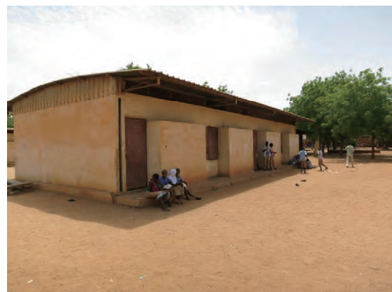
写真6：既存校舎外観 1960年代に建設された教室棟 (III-2 第1ガルバ・ジボ中学校)
