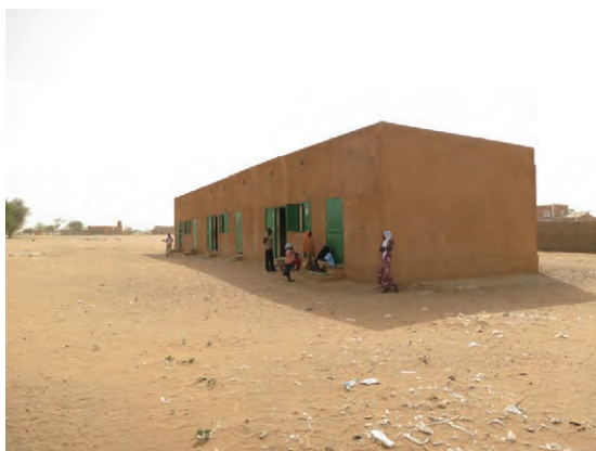
写真5：既存校舎外観 廊下のない教室棟 (I-4 セニ・アルズマ中学校)
