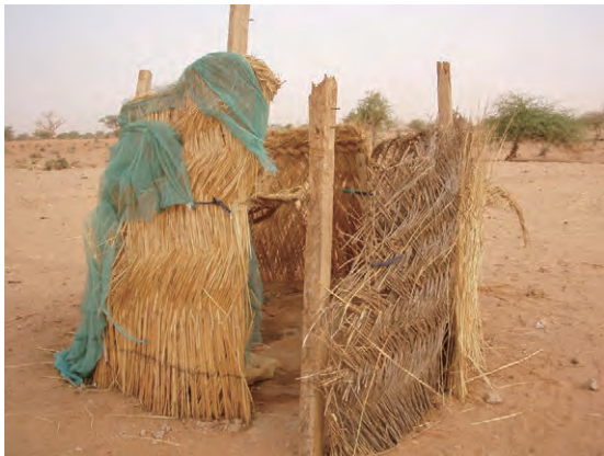
写真 15：藁葺トイレ 藁で囲まれただけのトイレ (Ⅰ-4 セ仁・アルズマ中学校)
