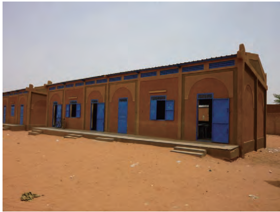
写真 19：イスラム開発銀行（BID）支援による 中学校 欄間にガラスを採用して採光を確保している。 （FA-1 FA サレ中学校）
