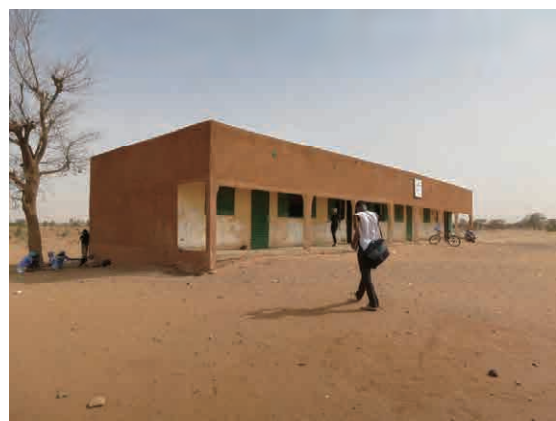
写真 8：規格外の教室棟 カタール・チャリティ支援による教室棟。各教室は標準タイプの1/2程度の面積しかなく使にくい。(I-4セ仁・アルズマ中学校)
