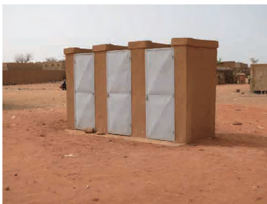
写真 13：既存トイレ ジェンダー配慮がなされておらず、目隠し壁がないトイレ棟。(Ⅱ-3 コイラ・テギ中学校)
