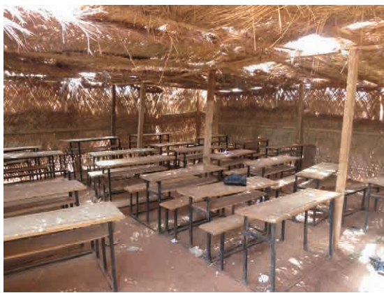
写真3：藁葺教室の内部 新学期より8ヶ月間使用したため、屋根の藁が傷んでいる。(I-3 ストゥレ中学校)
