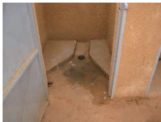
写真 14：既存トイレ内部 左のトイレのブース内部。便器がない形式。(Ⅱ-3 コイラ・テギ中学校)
