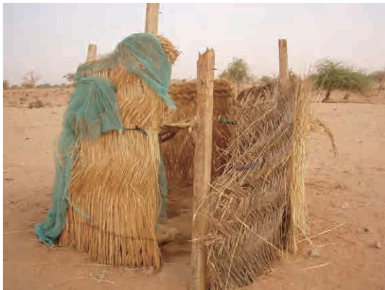
写真 15：藁葺トイレ 藁で囲まれただけのトイレ (Ⅰ-4 セ仁・アルズマ中学校)
