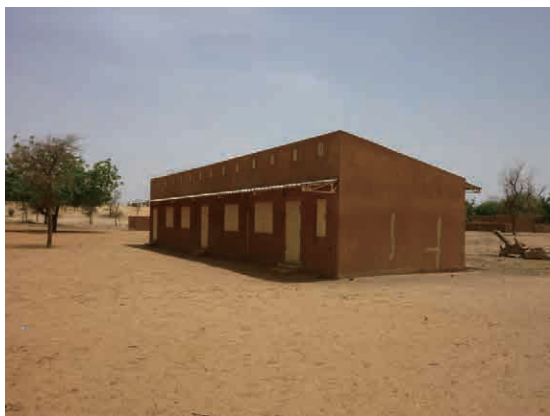
写真 23：フランス開発庁（AFD）支援による小 学校 外廊下に屋根がついたタイプの教室棟。
