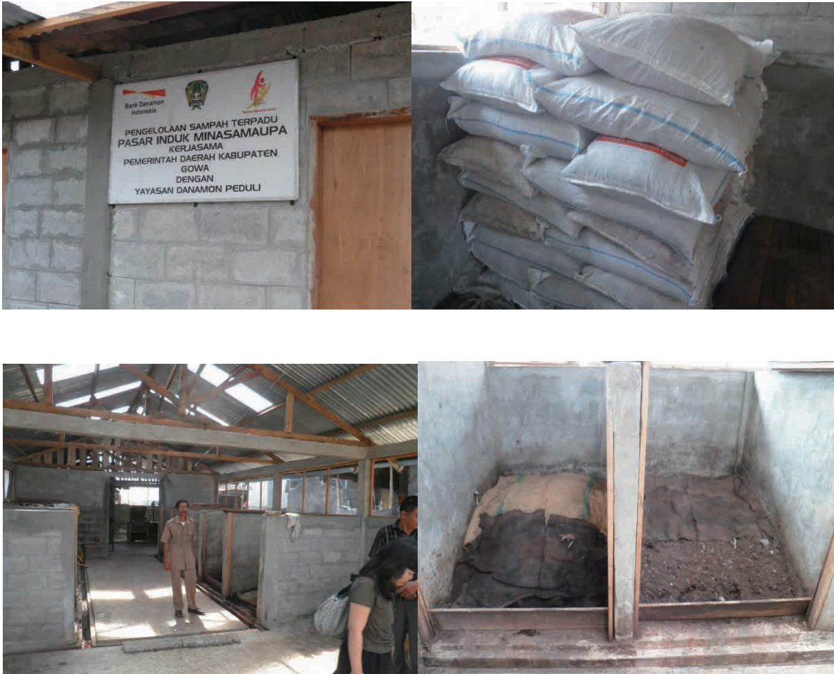
図 6 - 13 ゴワ県における市場に設置された小規模コンポスト施設
