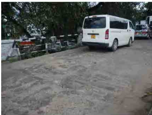
舗装の消耗 Colombo
