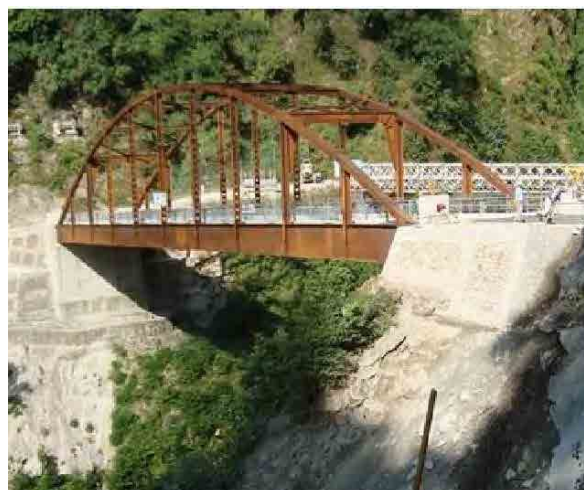
[耐候性鋼材を使用した橋梁架設例]
