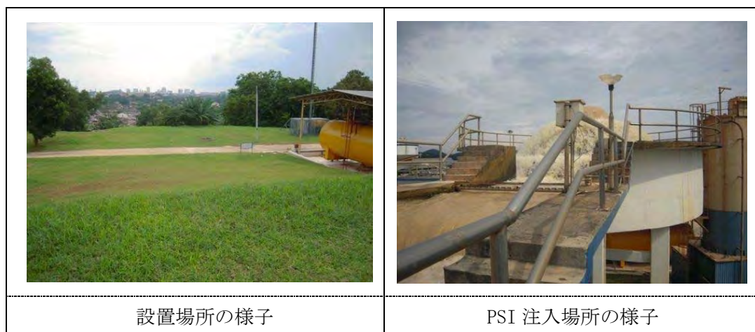
写真 4.2 施設設置場所の概要 (Bukit Sebukor 浄水場)
