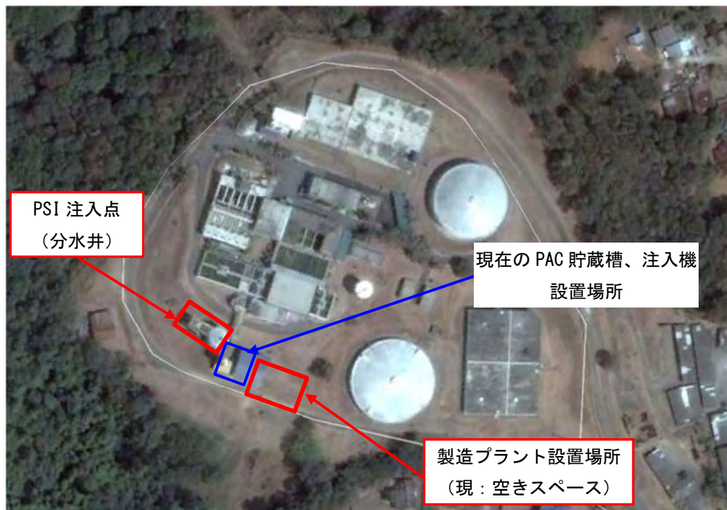
図 S-5 施設設置場所の概要（Bukit Sebukor 浄水場）
