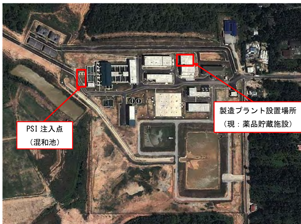
図 S-4 施設設置場所の概要 (LABU 浄水場)
