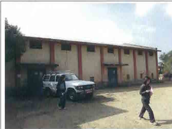
農業資材投入公社（AICL）ドゥリケル事務所の倉庫
