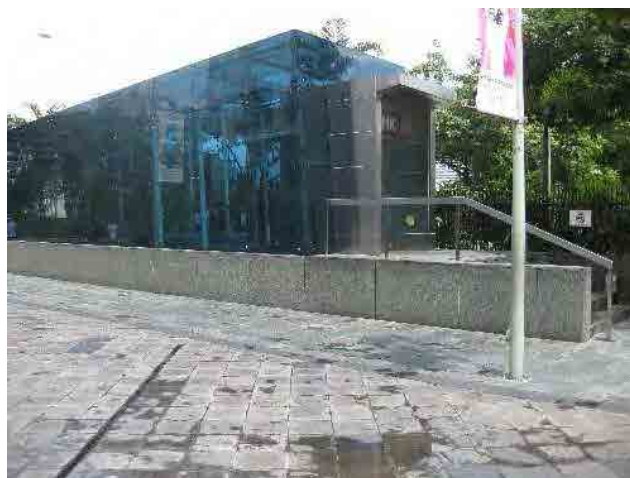
図-4.3.49 地下連絡路洪水対策のイメージ写真 (シンガポール地下道出入口 出典：調査団)
