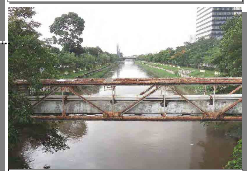
河川 (Banjir Kanal) を横断する管路橋梁
