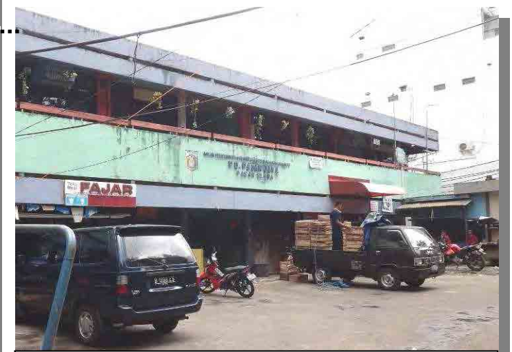
公共用地に建つ、PASAR BLORA 公営市場
