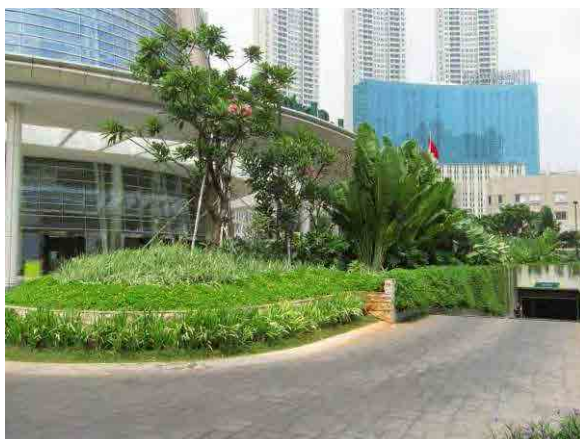
壁土留による植栽厚確保
