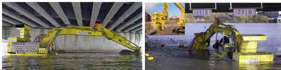
図-4.3.37 水陸両用バックホーによる浚渫 (左) とサンドポンプによる浚渫 (右)
