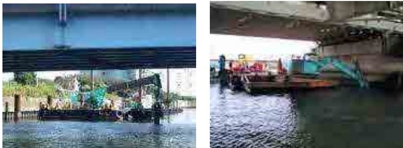
図-4.3.36 台船上のクレーン (左) やバックホー (右) で浚渫
