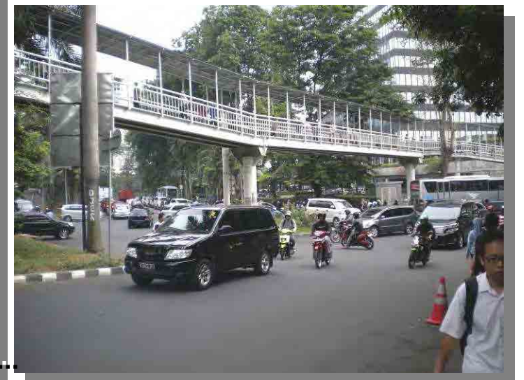
TransJakarta Koridor1 と Koridor4&6 連絡通路
