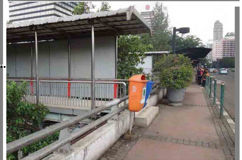
鉄道 Sudirman 駅と Dukuh Atas 橋梁の接続部
