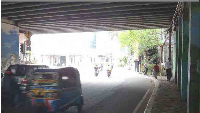
Dukuh Atas 橋梁の北側トンネル、歩道幅員は 2m 未満であるにも係らず、ラッシュ時には多くの歩行者が利用する
