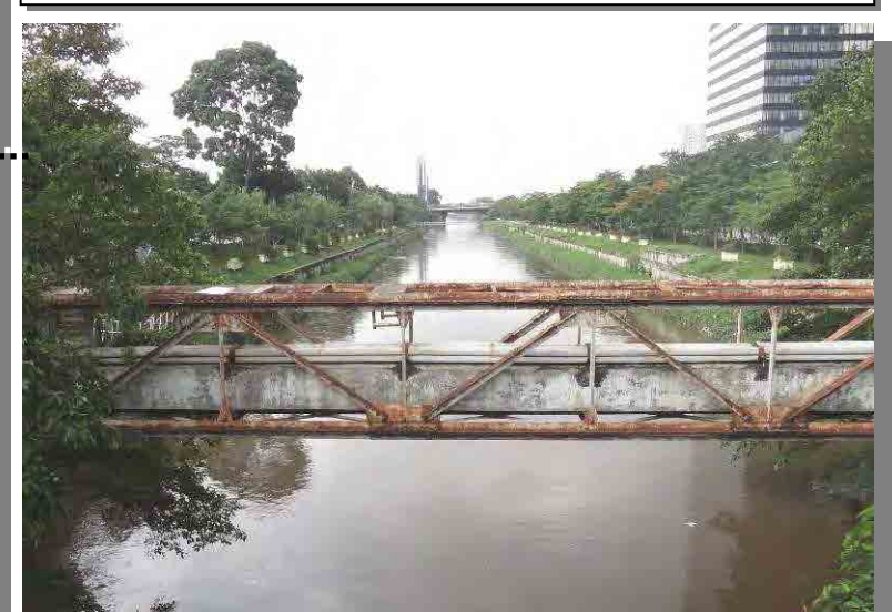
河川 (Banjir Kanal) を横断する管路橋梁
