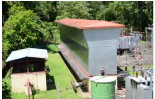
写真-28 30 kV スイッチギア屋外形配電盤
