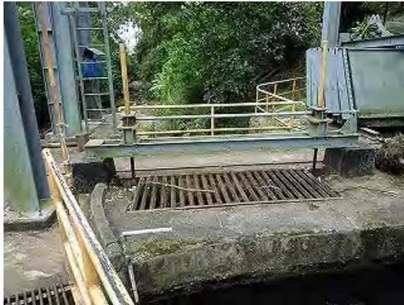
写真-7 土砂吐きゲート現況
