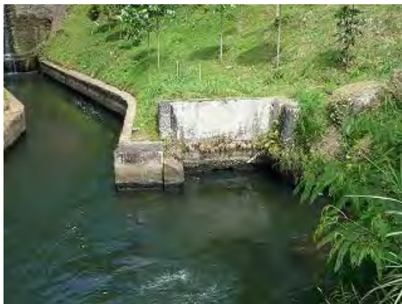
写真 6-1 放水庭 (左側が2号および3号水車用放水路出口、 右側が1号水車用放水路出口)
