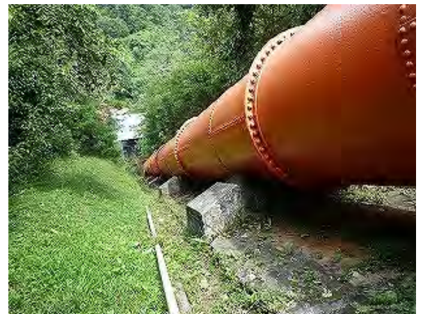
写真 5-2 1号水圧鉄管全体図 (サージタンク側より下流方向を見る)
