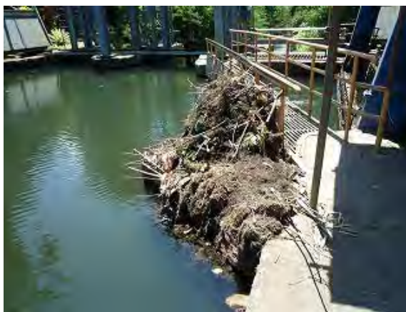
写真 2-1 取水口（右側が取水口）
