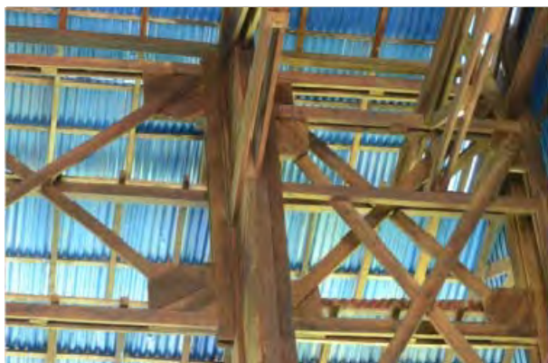
写真-19 1号機用発電所建屋内部 木造構造
