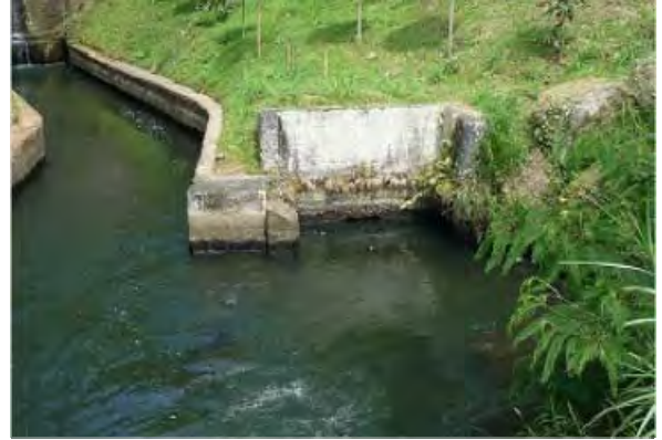
写真-26 放水路 左側が2、3号水車用放水路出口、右側 が1号水車用放水路出口
