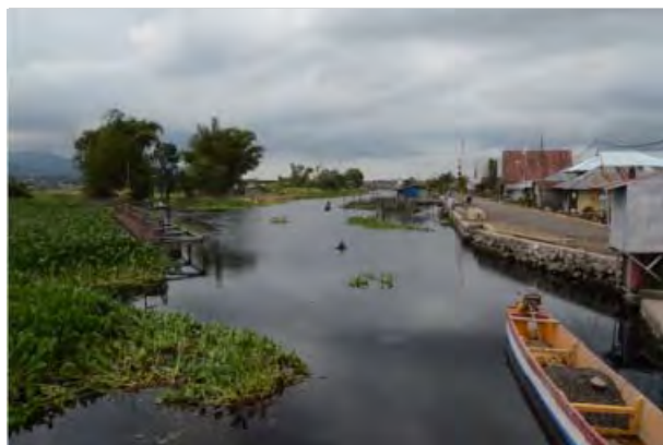
写真-1 導水路上流側の現況
