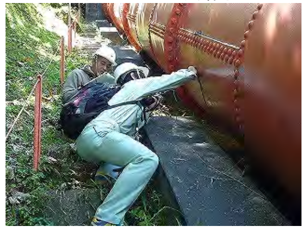
写真 5-10 板厚測定状況
