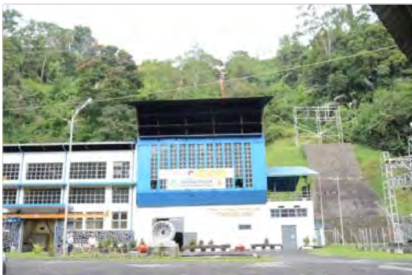
写真-17 トンセアラマ発電所全景 右側建物が1号機用、左側が2、3号機用
