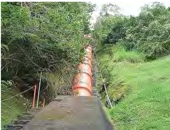
写真 5-1 1号水圧鉄管全体図 (発電所側より上流方向を見る)
