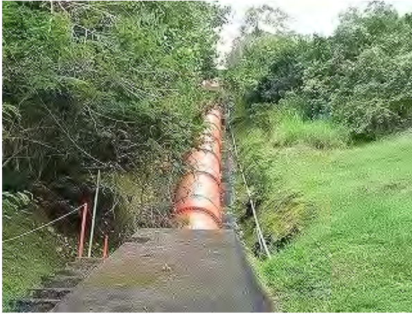
写真-13 1号水圧鉄管全景 (発電所側より上流方向を見る)
