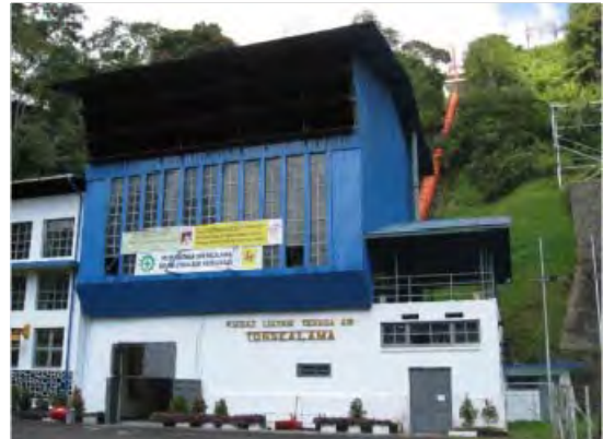
写真-18 1号機用発電所建屋外観
