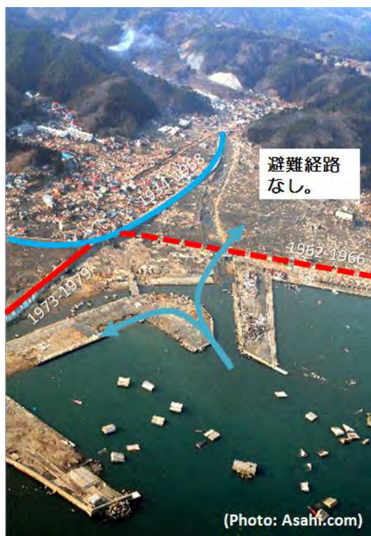
防潮堤。内側は旧市街地。 赤破線：60年代以降作られたコンクリート製防潮堤。 震災の津波で倒壊した。 赤実線：73年以降作られた防波堤。 うす青矢印：東日本大震災の津波の方向
