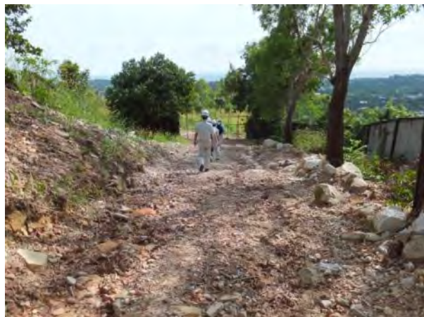
Eb (DIP 管 φ300) : 地盤はほぼ 100% 岩盤。敷設日進 50m 程度。Eb 路線は 8 割埋設が終了した。
