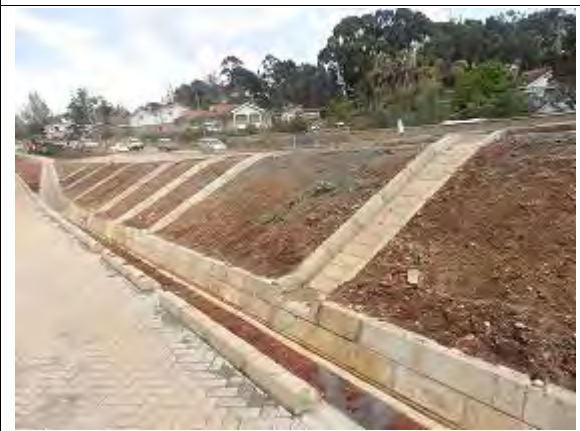
写真 - 17 コンクリート法面側溝
