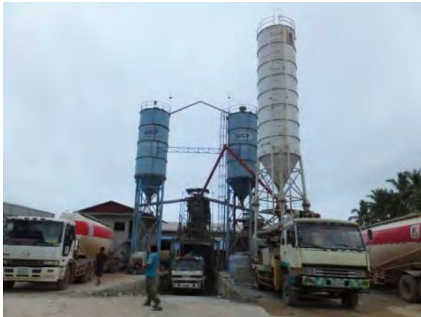
コンクリートプラント<シハヌークビル>：プラントの生産能力は60m 3 /h。材料はコンピュータ制御にて重量計量されている。圧縮強度試験もここで行う予定。
