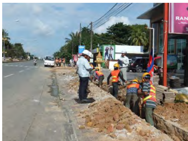
R5 (サービス管 φ50) : 歩道部分を掘削して配管を埋設している。手掘り作業であり、順調に進捗している (300m/日)。
