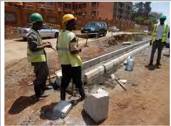
写真 - 16 コンクリート縁石
