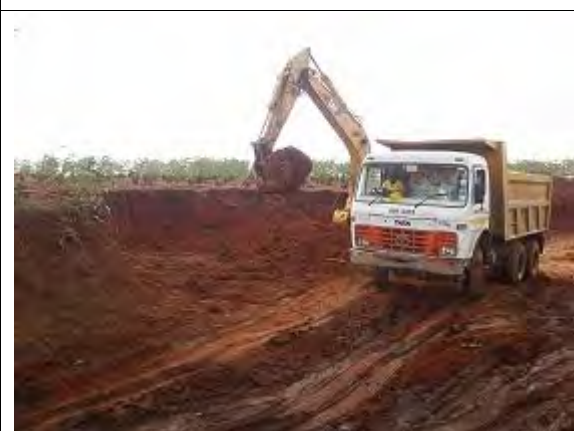
写真 - 20 土取り場（現場から約35km）
