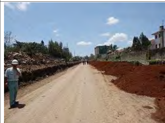
写真 - 8 不良土置換え (不良土撤去後に良質土搬入)
