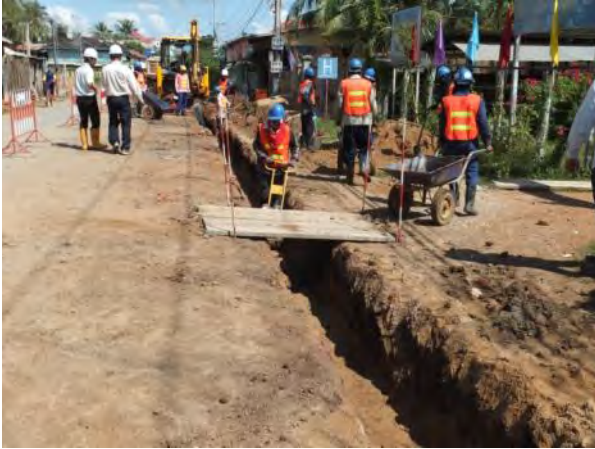
R11-2 (HDPE \phi 100) : 小型ローラによる転圧中。このほか、ランマによる振動締固めも行っている。
