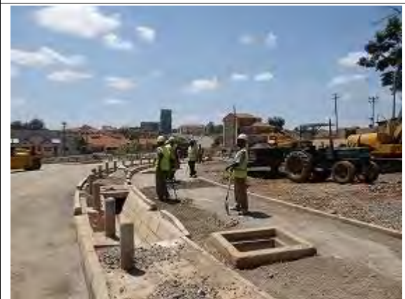
写真 - 18 交差点部のコンクリートガードポスト
