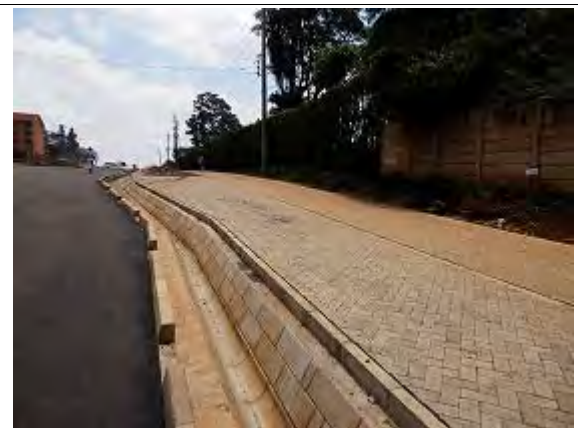
写真 - 12 歩道部のインターロッキングブロック舗装
