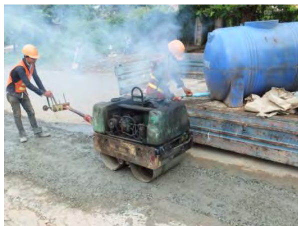
R3 (DIP 管 φ250) : 緩い下り坂であることから、埋設後にセメント混合砂利で仮復旧を行っている。
