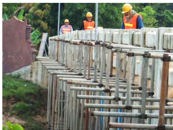
E10 (φ100 橋梁添架) : 仮設足場の施工中。
