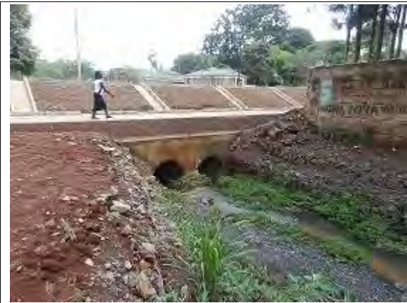
写真 - 13 コンクリートパイプカルバート
