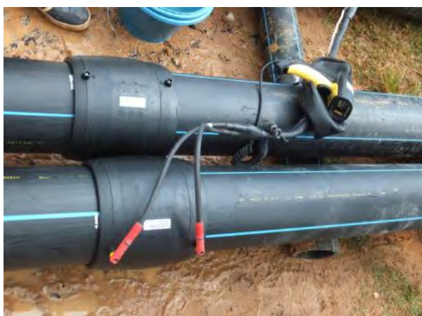
E8 (HDPE φ150) : EF 接合。継手のバーコードを融着機が読み取り、継手の種類、融着に必要な冷却時間が表示される。
