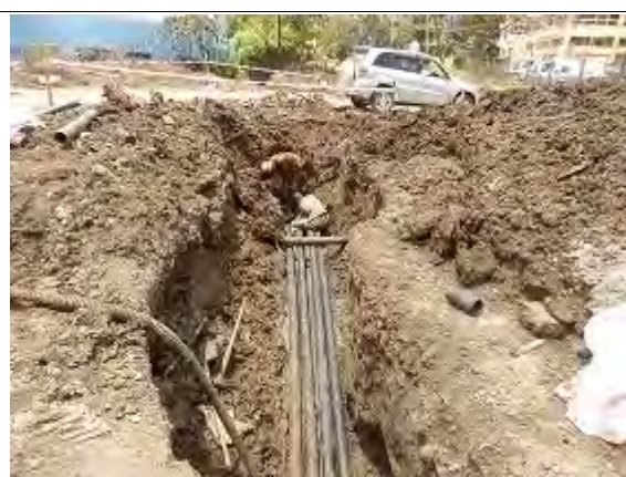
写真 - 23 支障物件（移設中の通信ケーブル）
