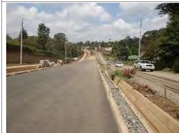
写真 - 5 2車線開発部 (右側はROW内の将来開発エリア)
