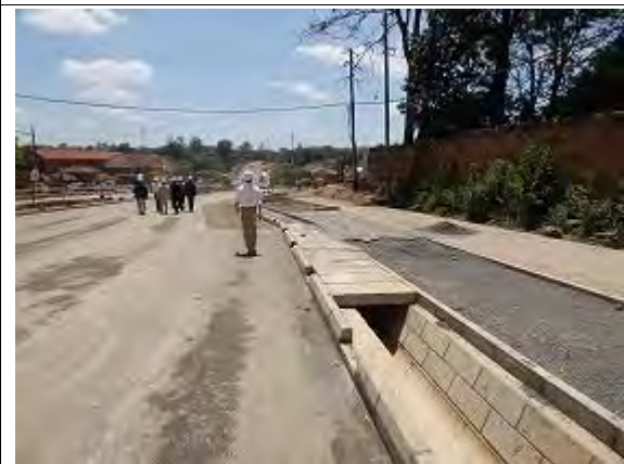
写真 - 15 コンクリート側溝
