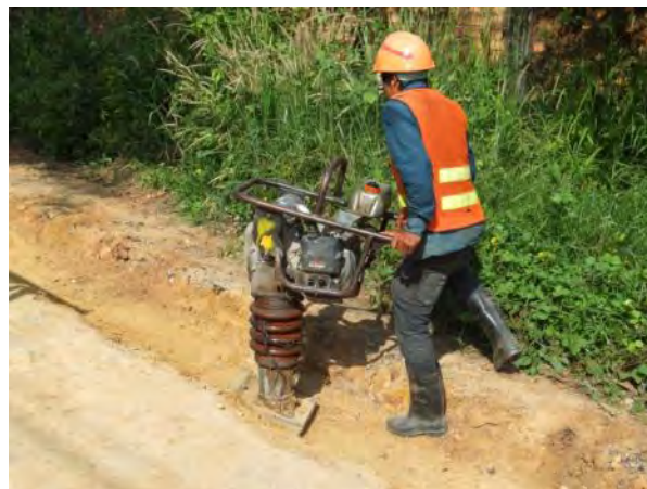
E4 (HDPE 管 φ100) : 埋戻し土の振動締固めを行っている。
