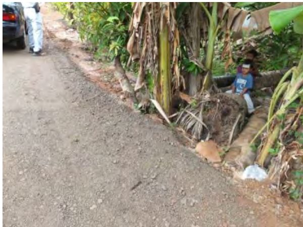
E1 (HDPE φ100) : 別案件で簡易舗装を行っており、本件にて配管埋設した箇所を施工中であった。
