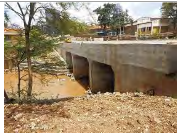
写真 - 14 コンクリートBoxカルバート
