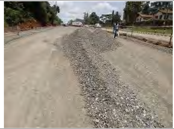
写真 - 10 下層路盤工 (材料敷き均し中)
