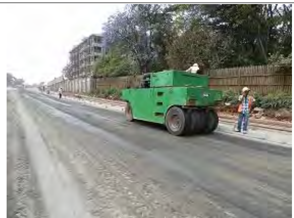
写真 - 11 上層路盤工 (粒度調整碎石タイプ)
