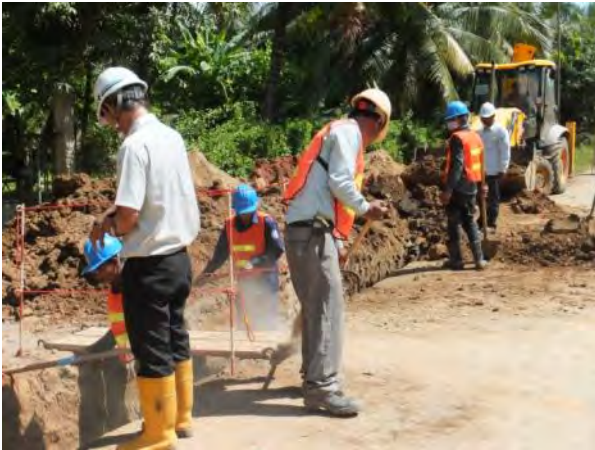
E9-2 (DIP \phi 250) : 埋め戻し作業と同時に箒で清掃しており、工事現場の清掃にも配慮が行き届いている。
