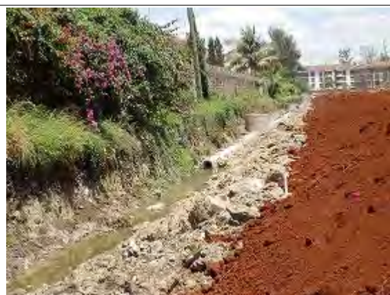
写真 - 22 支障物件 移設中の下水管
