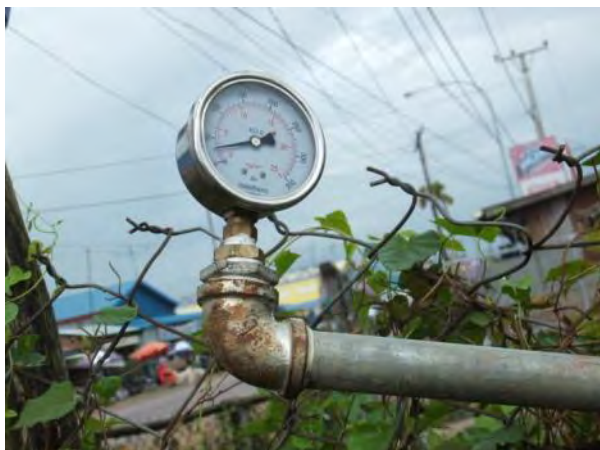
R12 の水圧試験の準備 : 0.9MPa まで圧をかけて 30 分放置した後 0.7MPa で 4 時間の水圧試験と漏水試験を実施している。
