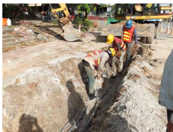
R4 (DIP 管 φ300) : 電線管が出てきたことから手掘りにして対応している。
