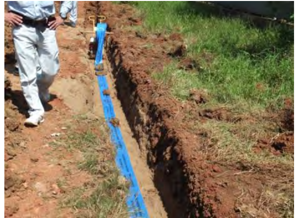
R4 (HDPE \phi 100) : 一層目の砂の上にテープを置いている。テープには「この下水道管あり」と英語・クメール語で書かれている。
