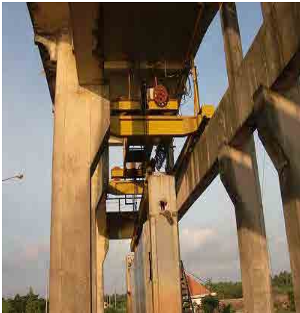
Cần trục được trang bị để nâng và chở cánh cửa công. Cần trục thường được vận hành bằng mô-tơ điện.
