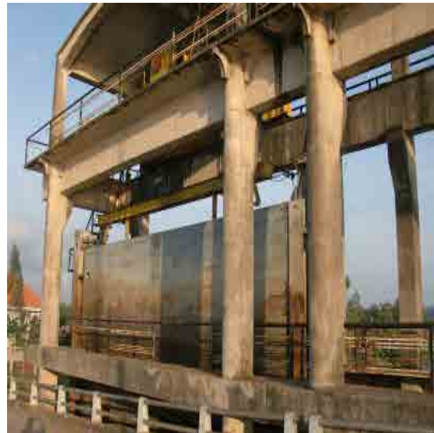
Thiết bị nâng để sửa cánh cửa công: Nếu chiều cao của cánh lớn, công phải có trụ cao.
