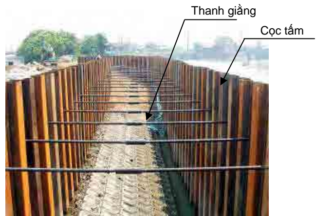
Mặt giữa hai lớp cọc thép tấm. Cọc tấm ở cả hai bên được nối với các thanh giềng và ở giữa được lấp bằng cát.
