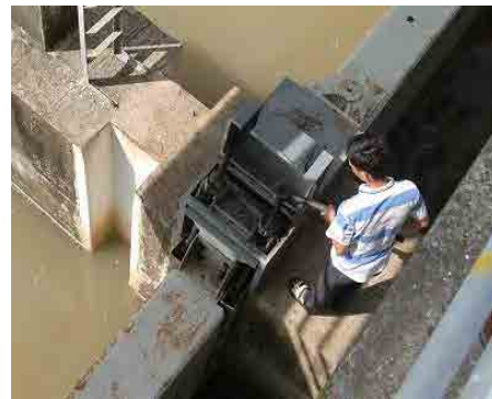
Khi cần phải đóng cánh, nhân viên vận hành sẽ vận hành thiết bị khoá và cố định nó lại.
