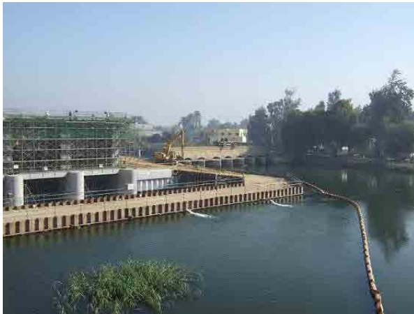
Ví dụ về phương pháp sử dụng hai lớp cọc thép tấm: Cọc thép tấm và cát lấp có thể đảm bảo khả năng chặn nước.
