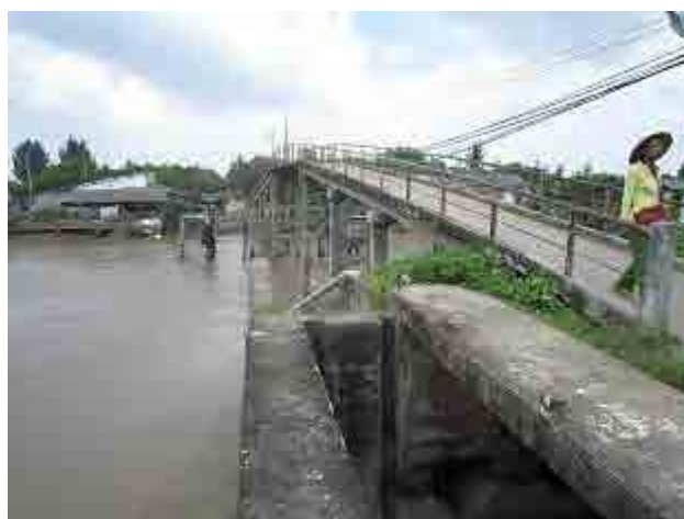
Một trong những địa điểm tiềm năng để lắp đặt cửa cống. Cửa cống với các thiết bị khác nhằm ngăn mặn vào các khu vực ven biển.
