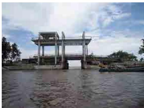
左側写真は水路内に自国予算で建設された防潮水門である。道路と併設されており、地域の重要な交通網の確保に役立っている。右側の水門は SPL 資金で建設された防潮水門であり、タイ湾に注ぐ水路の最末端に建設されている（水門の向こう側はタイ湾である）。
