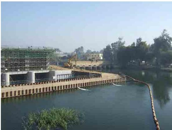
2 重シートパイルの施工例：2 重のシートパイルの間に砂を盛ることで十分な止水性が確保される。
