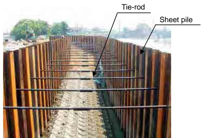
2 重シートパイルの施工例（断面）：2 重に打ち込まれたシートパイルはタイロッドにより結合され、また、砂を間に入れることで安定性が増す。
