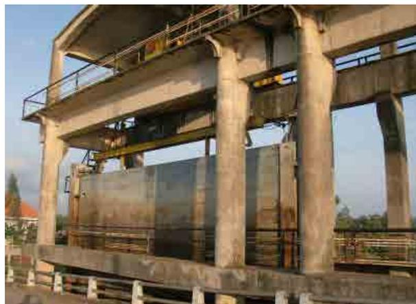
改修時に引き上げられた角落とし：角落としの高さに合せたピアの高さが必要となる。
