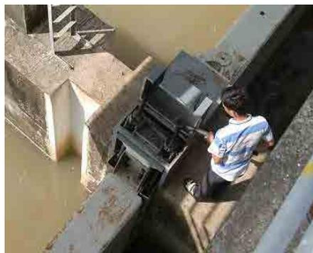
スイングゲートの閉鎖が必要な場合、写真の固定ハンドルで固定される
