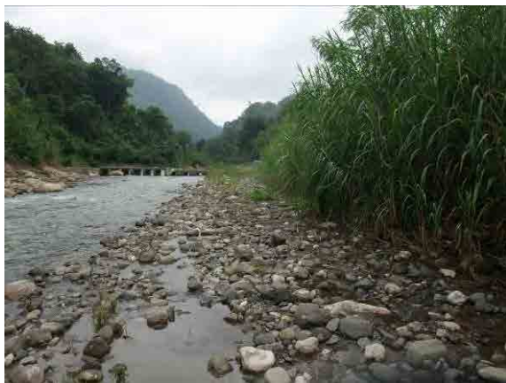
写真-7 : 発電所予定地の現状。この付近で放水される。この下流には既設の道路・橋があり、ここから資機材の運搬が可能である。
