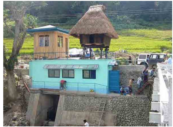
写真-2：棚田保全資金創出を目的に開発されたアンバングル小水力発電所。これにより創出される基金は必要保全資金の10%程度を充当するに過ぎない。
