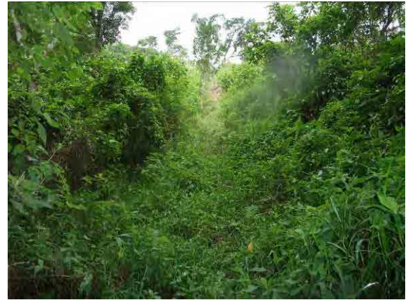
写真-6 : 水圧鉄管設置ルート of 現状。水槽から延長約150mの水圧管路により発電所に導水し、この間の落差約52mを利用して、最大820kWの発電を行う。
