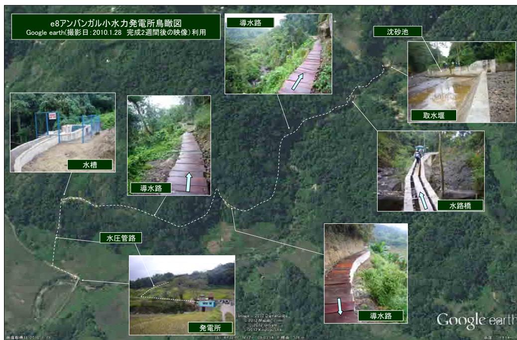
図 1-3 e8-アンバンガル小水力発電所(写真:TEPSCO 撮影)
