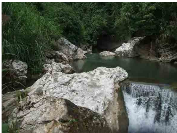
写真-3：既設灌漑用取水堰の現状。現在は取水されておらず、河川水は堰堤を越流している。プロジェクトではこの堰堤を改修（約0.3m嵩上げ）し、最大 2.0\text{m}^3/\text{s} の取水を行う予定。
