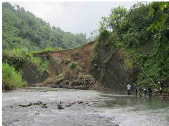
写真—7b TD.500m 付近、川が流路を大きく左へ転じる位置（崩落後；10月） 露頭中央部の緩んだ箇所が地中に染み込んだ多量の水の影響で崩壊した
