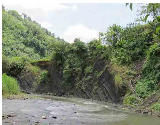
写真—7a TD.500m 付近、川が流路を大きく左へ転じる位置（崩落前；8月） 露頭は一面で連続しているが、中央部は節理に富み緩んでいる
