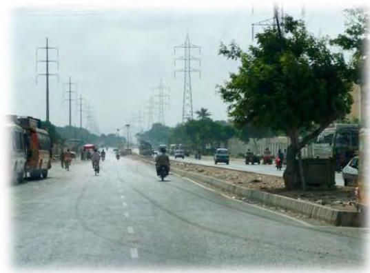
拡張されたメヘラン道路
