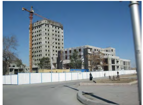
写真 16 アシガバット市中心部の 官公庁建設現場 （非常事態省が入る予定のビル）
