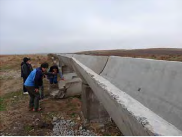
フリュームの継ぎ目の補修状況の視察
