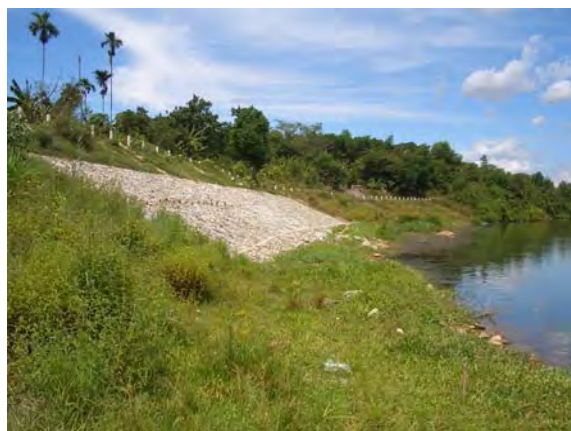
プロジェクトが実施した河岸侵食工事
