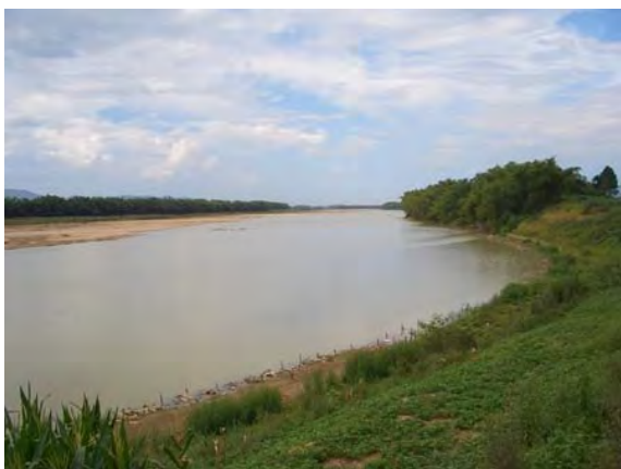
プロジェクトが実施した伝統的工法を用いた河岸侵食
