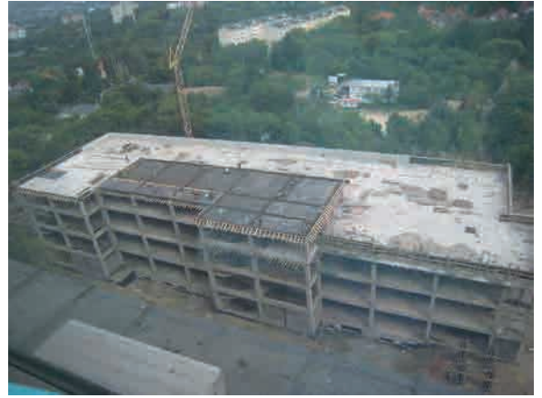
建築中の新外科棟
