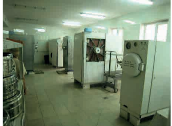
中央滅菌室。古い機材が多く、両扉パススルー型の機材の片側の扉は使わず片扉として使用している。
