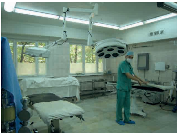
手術部の1室。无影灯、手術台、電気メスなど20年以上経過した機材が目立つ。医用ガス配管は我が国草の根無償で整備された。
