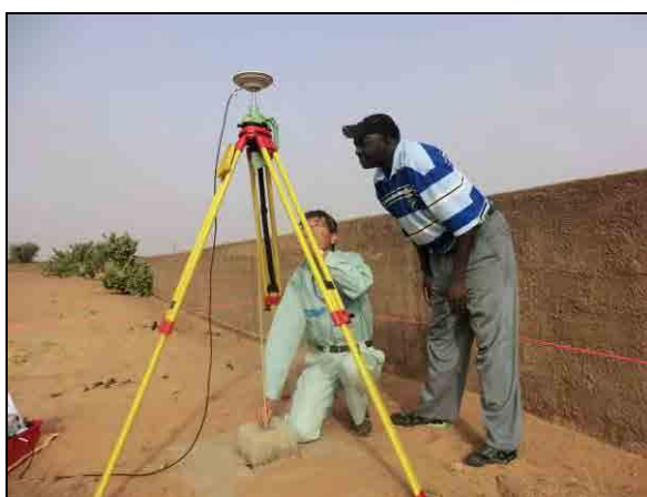
Photo 3-1 Encadrement pour la méthode d'installation du trépied
