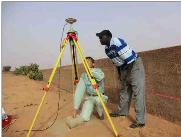
Photo 3-1 Encadrement pour la méthode d'installation du trépied
